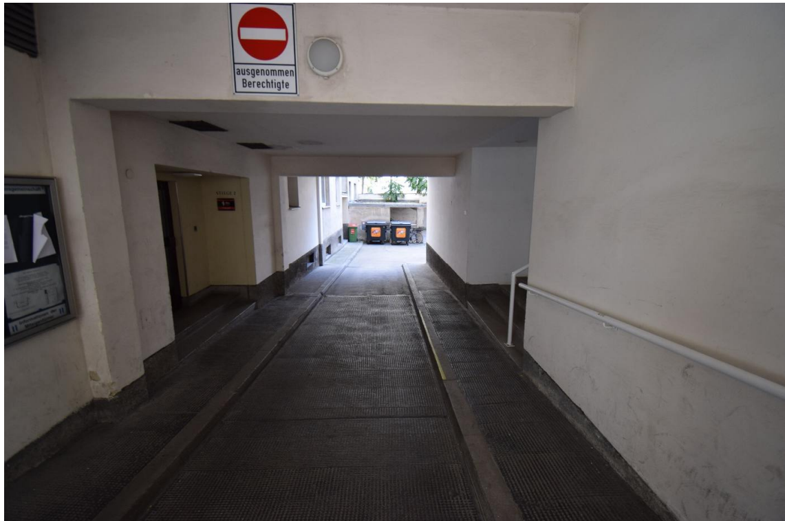
Durchfahrt – Zugang Stiege II links
