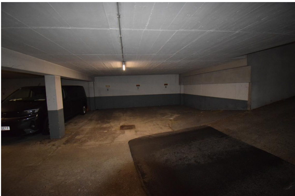
Stellplatz 6 bis 8 (Breite zwischen Wand und Betonfeiler 6,95m) – Schräge bei Stellplatz 8
