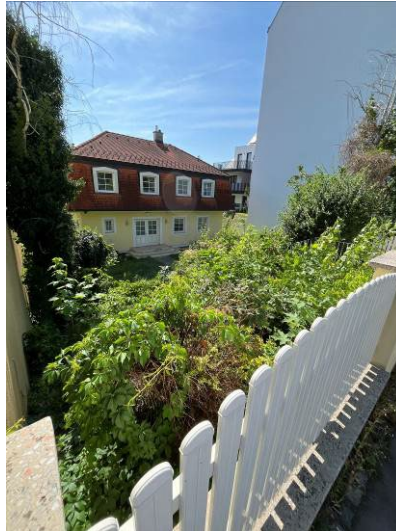
Abbildung 17: Ansicht des Bestandobjektes
