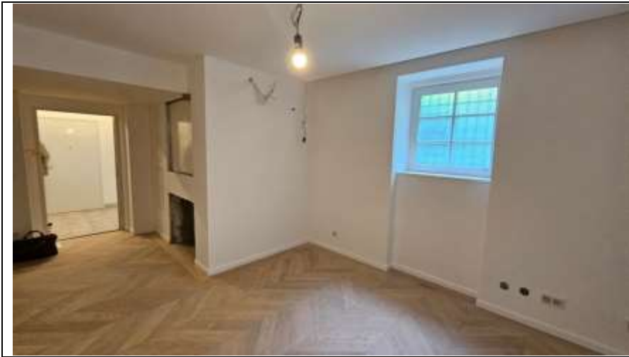
Abstellraum: Bodenbelag, Wände und Decke gestrichen
