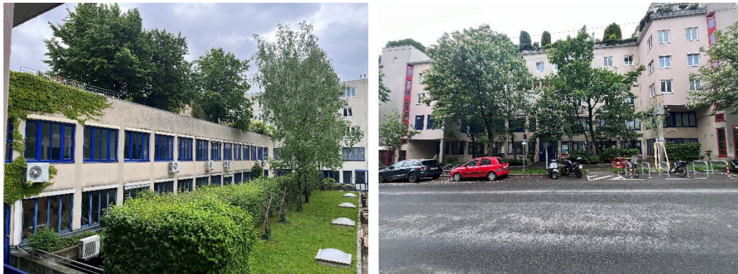
Abbildung 15: Ansichten des gegenständlichen Gebäudes
