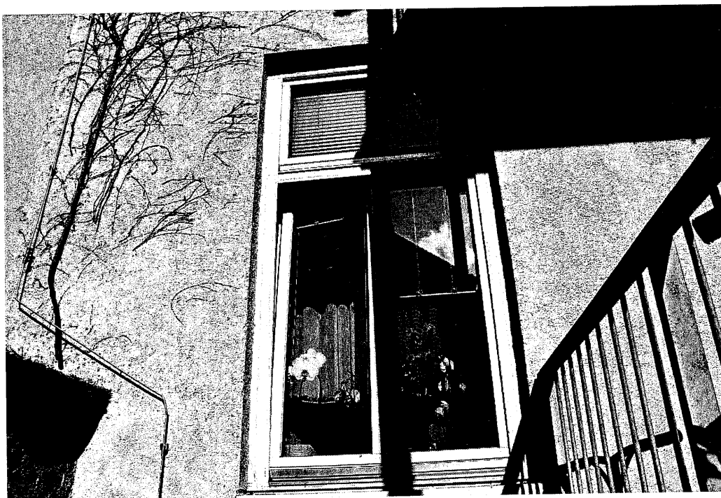
Bild 16: Fenster Hochparterre, Hof links
