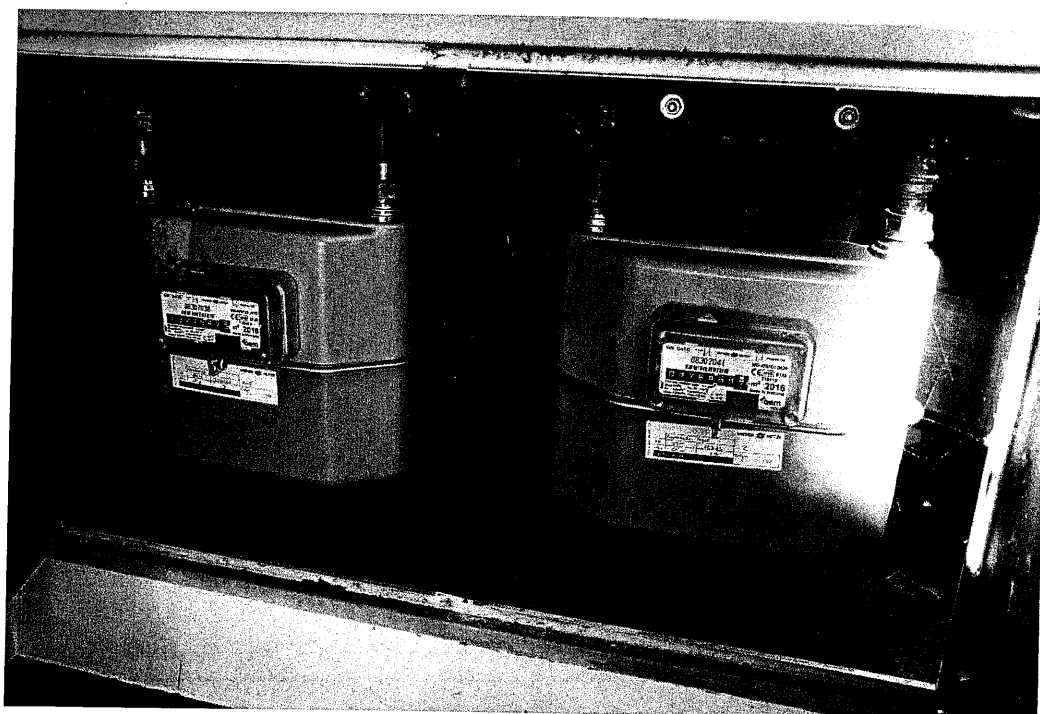
Bild 18: Gaszähler für jede Wohnung am Gang
