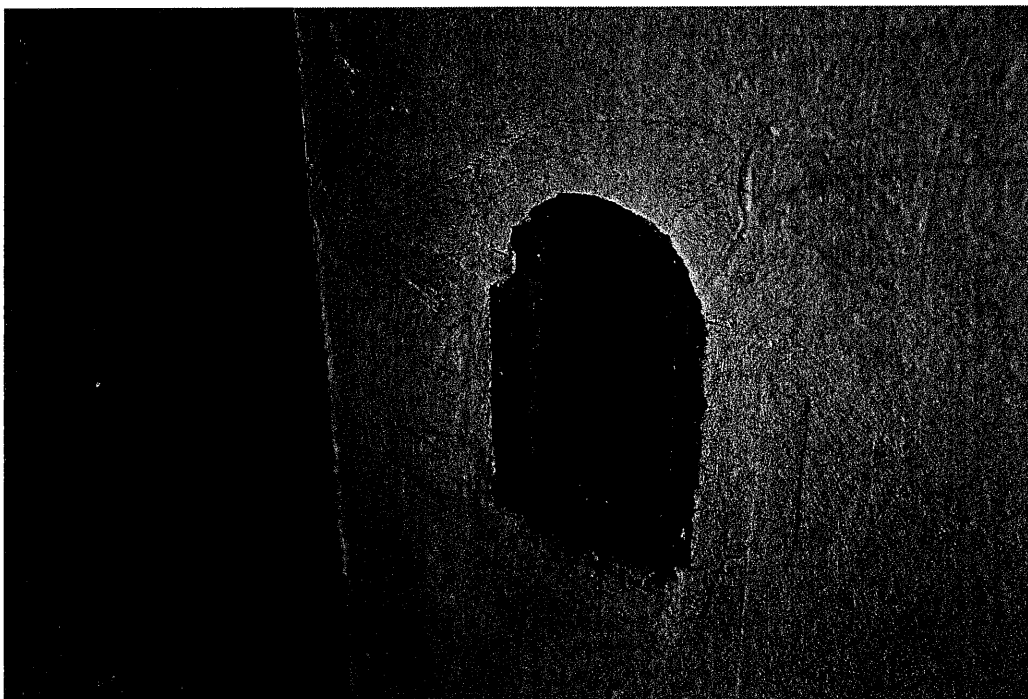
Bild 12: Lift Ruf Taste entfernt, Lift außer Betrieb
