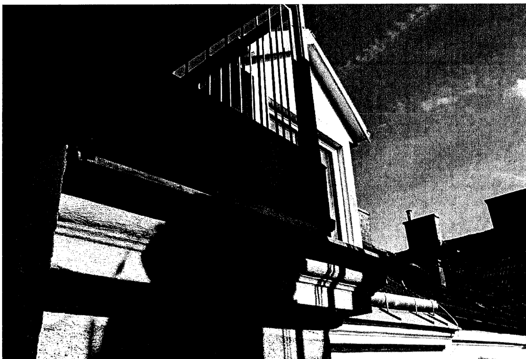
Bild 11: Dachschräge, Gaube rechts, Terrasse
