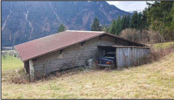
Abb 42: An der unverputzten bergseitigen Nordfront ist die massive Bauweise mit Hohlblock-Betonsteinen ersichtlich.
