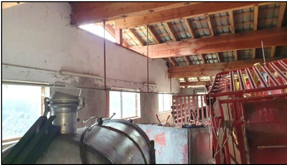
Abb 43 und 44: Innenansichten zeigen Baudetails wie die Melk-Vakuumleitung auf Höhe der Fensteroberkante und wandständige Futterbarren sowie die vielfältigen Nutzungsmöglichkeiten des Gebäudes
