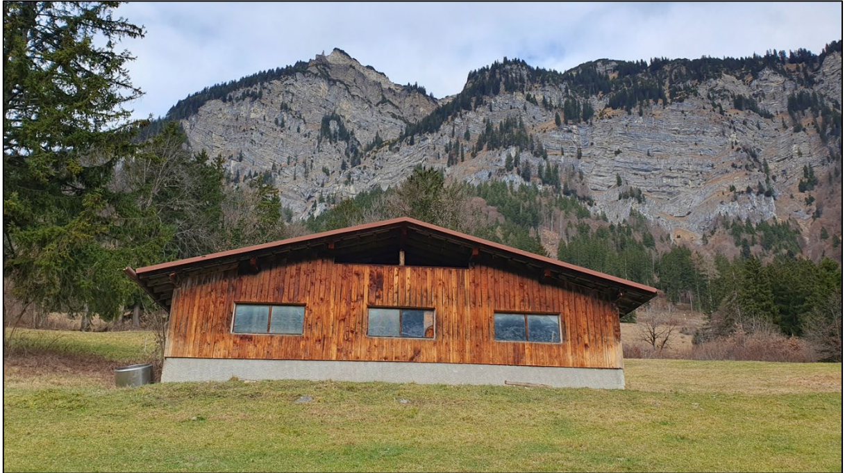
Abb 37: Die Südansicht entspricht dem altersgemäßen Gebäudezustand
