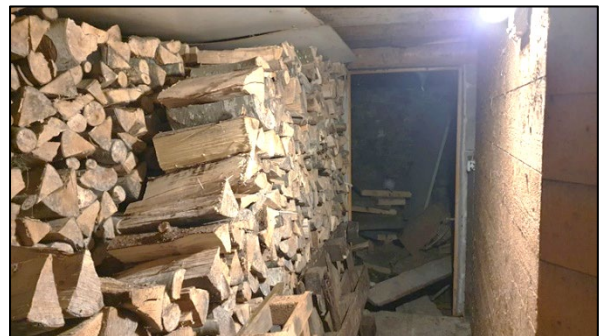
Abb 52: Der Keller dient überwiegend als Brennholzlager.
