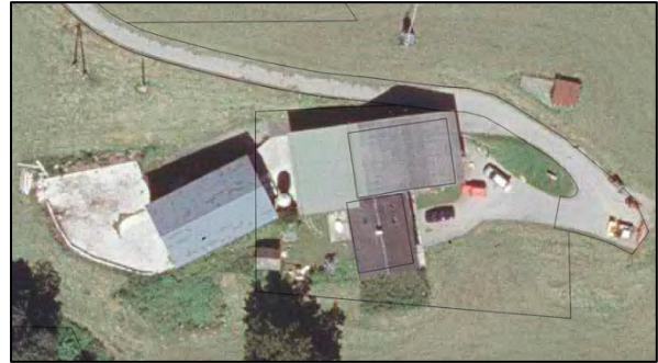
Abb 46: Luftbilder 2005-2012; Die Lücke zwischen den Wirtschaftstrakten ist mit einer Betondecke und einem größeren Dach geschlossen, die Auslauffläche befestigt und fix umzäunt.
