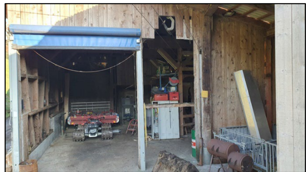
Abb 94: Einfahrtstor und Fassadendurchtritt der Seilbahn im westlichen Zubau des ursprünglichen Wirtschaftsgebäudes
