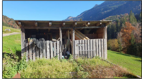
Abb 104: Vor der Süd-Ost-Ecke des Wohnhauses befindet sich ein einfacher Geräteschuppen mit Pultdach
