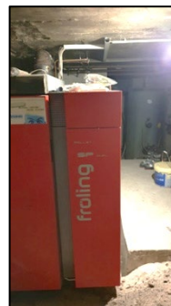
Abb 54 und 55: Scheitholzkessel mit Wirbelbrennkammer und Wärmepuffer für Brauchwasser und Heizung
