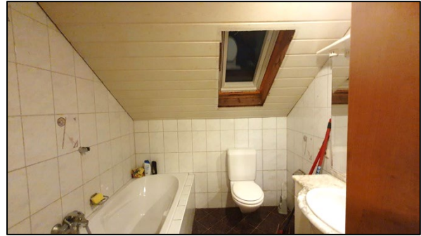
Abb 71: Im Bad sind die Dachschräge und die fehlenden Fensterleibungen raumprägend.
