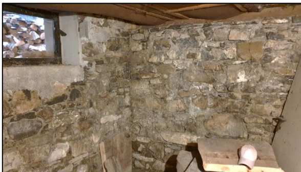
Abb 51: In das alte Steinmauerwerk wurden zeitgemäße Fenster einbetoniert.
