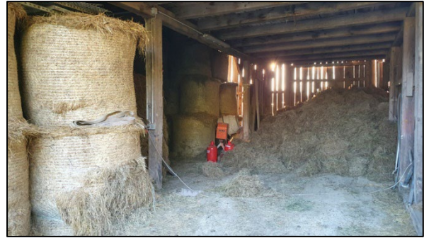
Abb 109: Heulager im OG
