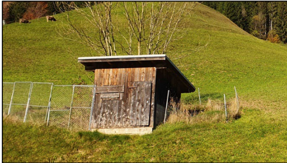
Abb 105: Der „Wellenbock-Stadel“ war früher mit einer Seilwinde ausgestattet, mit der Treib- holz aus dem Lutz-Stausee gezogen worden ist. Diese Nutzungsmöglich- keit ist nicht mehr gegeben.
