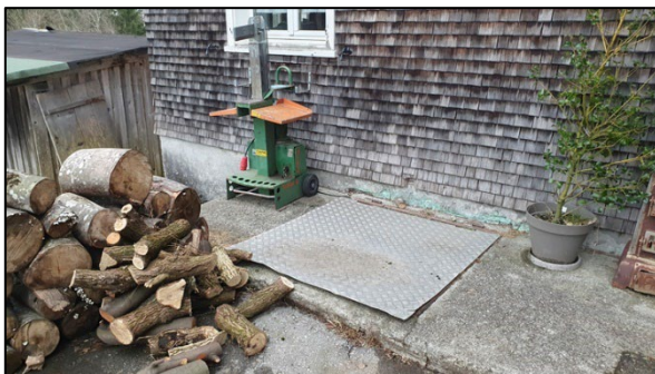
Abb 53: Außenansicht des Brennholzabwurfs in den Keller
