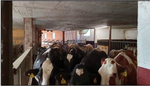
Abb 80: Blick von der östlichen Stalltür in den Stallabschnitt aus 1954
