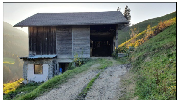
Abb 107: Ostseite mit der Zufahrt in das Obergeschoß; der gemauerte Vor- bau im Untergeschoß dient kei- nem besonderen Zweck.
