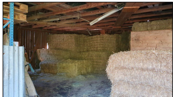
Abb 96: Blick von der Zufahrtsrampe in den Lagerraum über dem Laufstall
