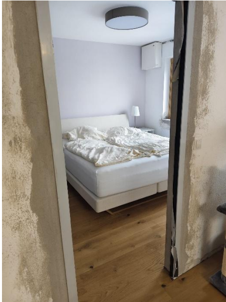
Abbildung 50: Schlafzimmer (notwendige Restarbeiten)
