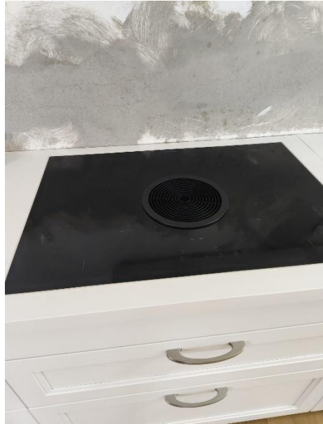
Abbildung 47: Küche (notwendige Restarbeiten)
