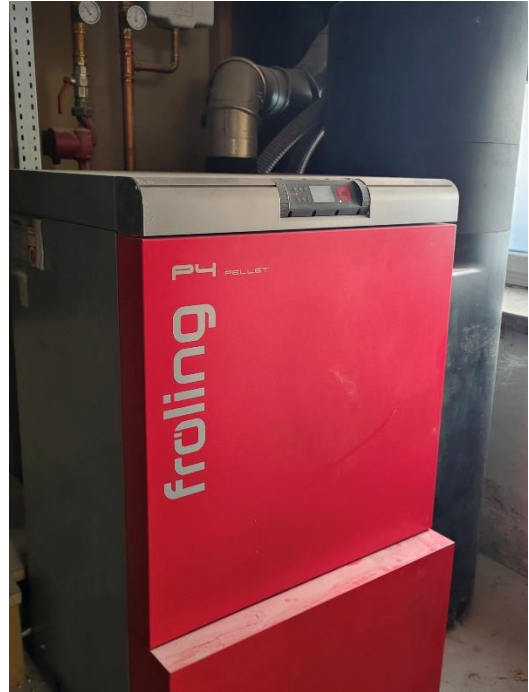
Abbildung 65: Pelletheizofen
