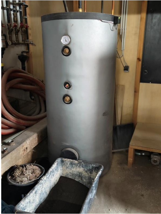
Abbildung 64: Warmwasserspeicher
