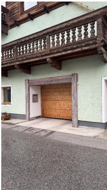
Abbildung 28: Untergeschoss, Einfahrt Garage (Untergeschoss)
