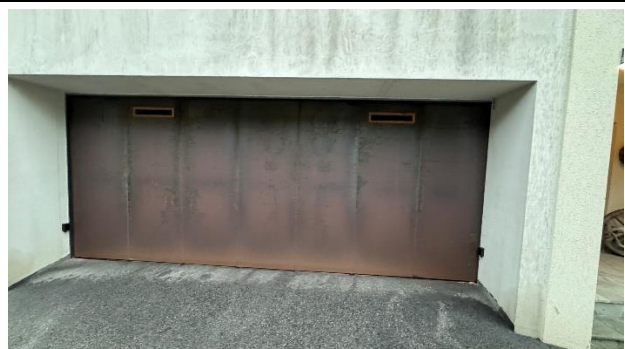
Abbildung 31: Erdgeschoss, Einfahrt Garage
