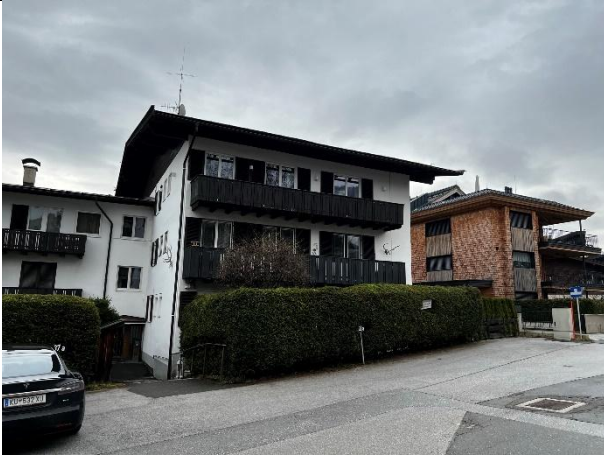
Abbildung 22: Ansicht von der Straße (Westen)
