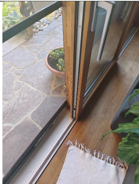
Abbildung 37: Zugang Garten Detailbetrachtung Fensterelement
