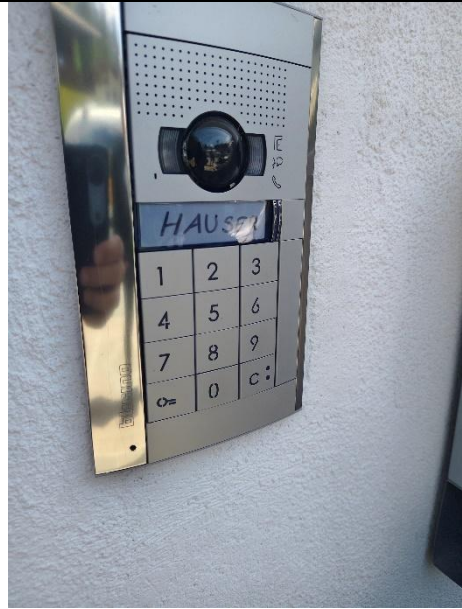
Abbildung 59: Klingelanlage mit Videofunktion
