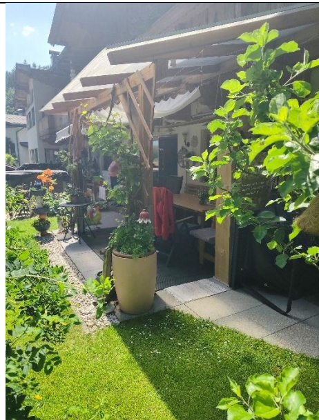
Abbildung 45: Außenanlage – Überdachung Terrasse
