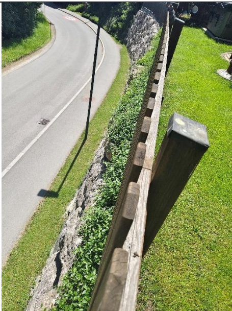
Abbildung 44: Außenanlage / Brüstung und Betonwand Richtung Straße
