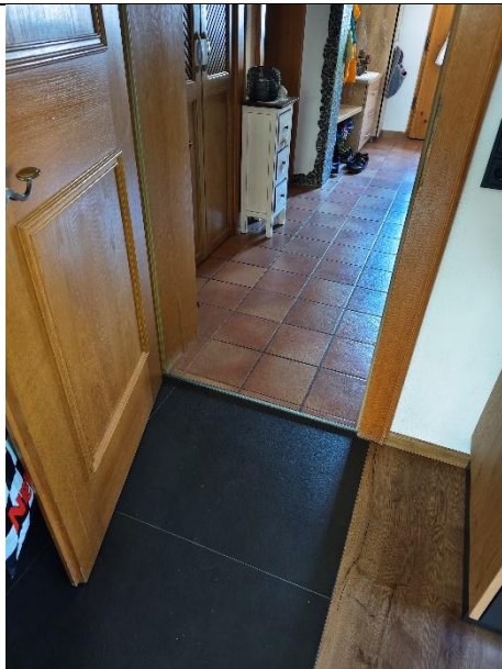
Abbildung 24: Flur EG / Tür und Bodenausführung
