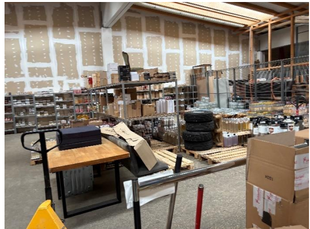
Abbildung 78: Lagerfläche / Ansicht Abtrennung in Leichtbauweise zu anderen WEG-Einheiten / Top 4 sowie hinten abgetrennt Top 5
