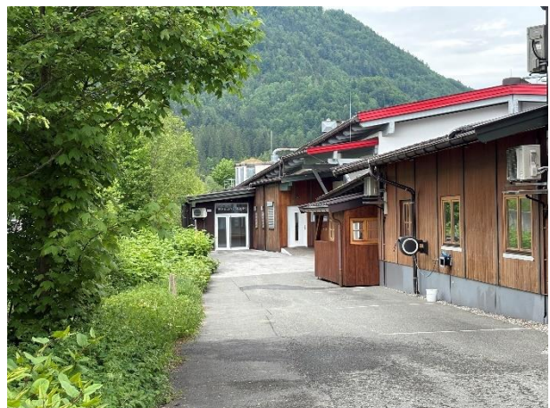
Abbildung 56: Außenansicht, westlicher Bereich
