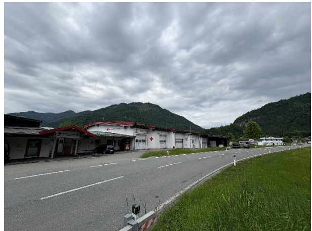
Abbildung 54: Außenansicht, Verlauf B 176
