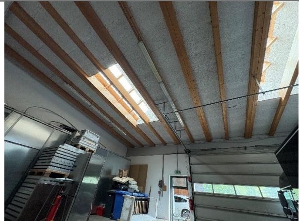
Abbildung 60: Detailansicht Anlieferungsbereich / Personenzugang / faktisch Allge- meinfläche
