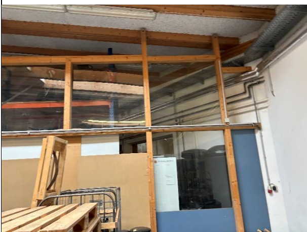
Abbildung 91: Lagerfläche / Bereich Top 5
