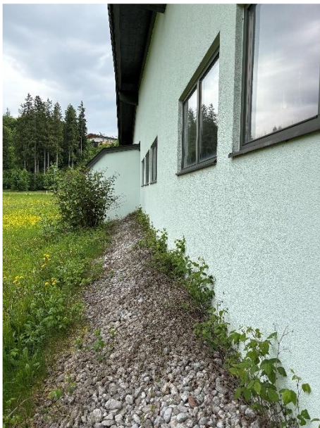
Abbildung 53: Außenansicht, Detailansicht Schotterung/Drainage
