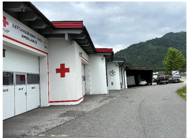
Abbildung 46: Außenansicht, Blick Richtung Norden
