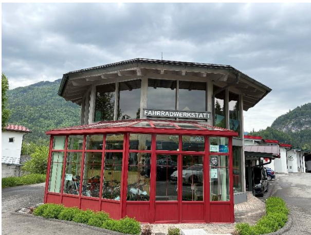
Abbildung 45: Außenansicht (Front anderer WEG Einheit)
