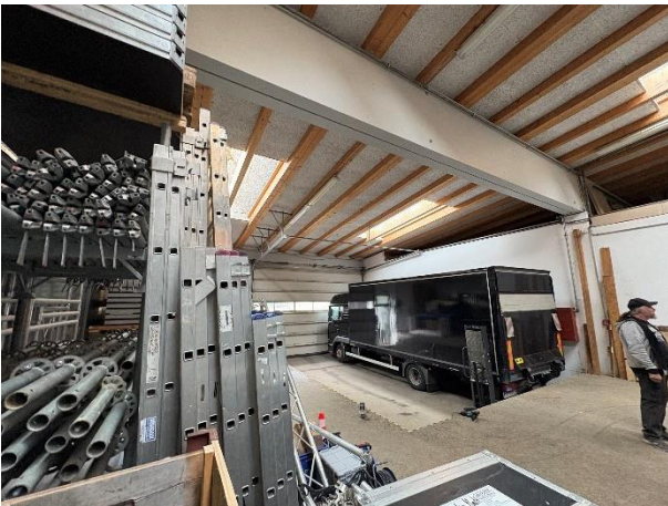
Abbildung 77: Lagerfläche/Einfahrt – Ansicht der Allgemeinbereiche
