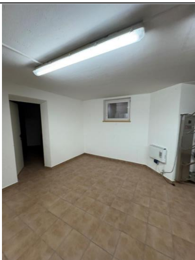
Abbildung 194: Kellerraum Top 6 & Verbindungstür Top 7
