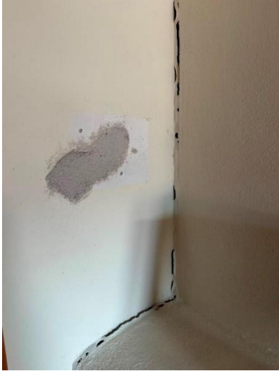
Abbildung 94: Setzungsrisse/Kamin
