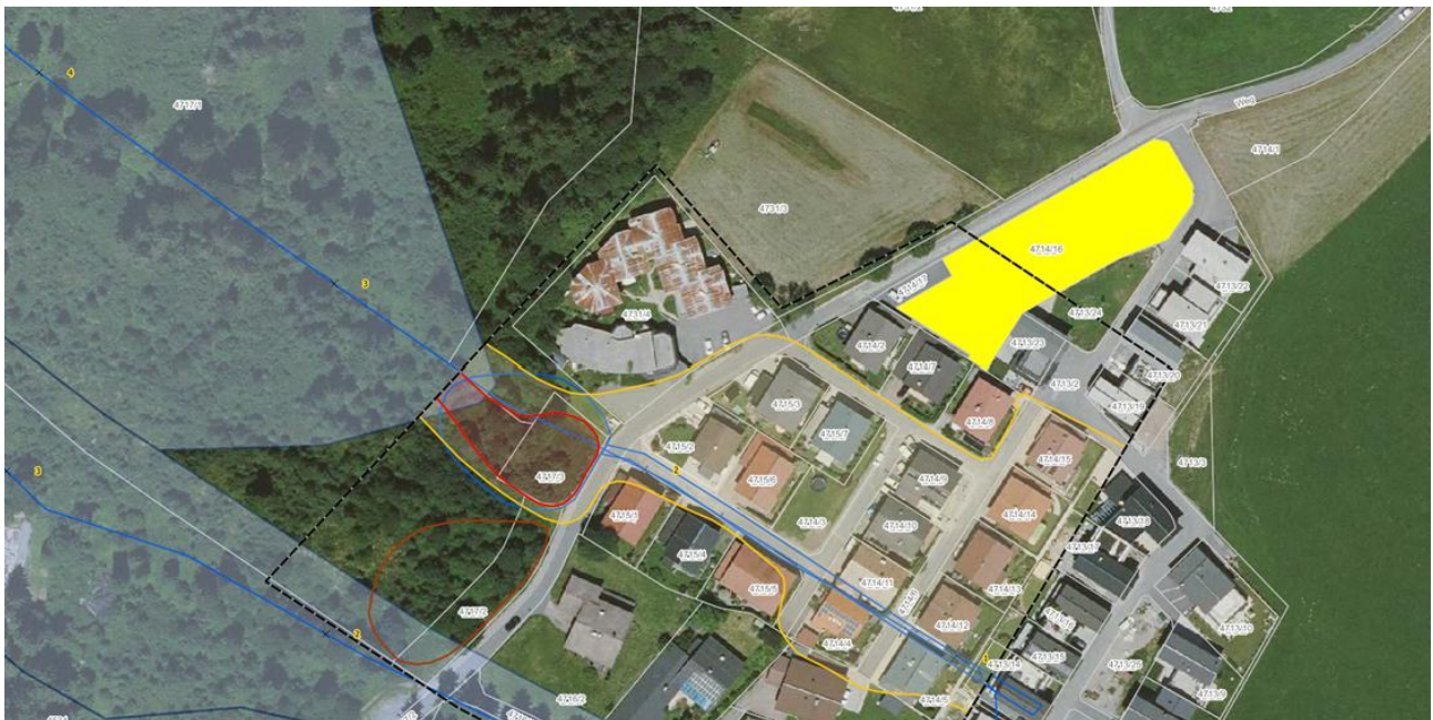
Abbildung 12: Überflutungsbereiche Oberndorf (Wildbach- und Lawinenverbauung, v. 23.03.2026) 13
