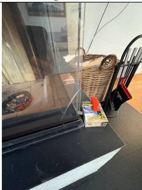
Abbildung 51: Kamin (Riss in Scheibe)
