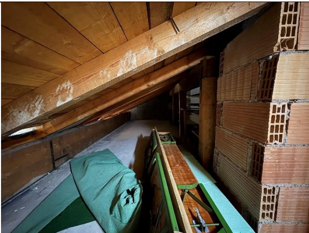
Abbildung 27: Abseite / Abstellraum in Dachschräge
