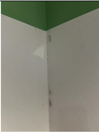
Abbildung 63: Feuchtigkeitsschaden (1/3)
