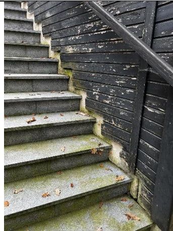
Abbildung 28: Treppe zum Wohnungseingang (2/2)
