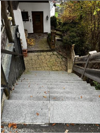
Abbildung 27: Treppe zum Wohnungseingang (1/2)
