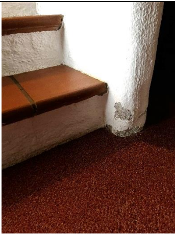
Abbildung 39: Abplatzungen Treppenaufgang
