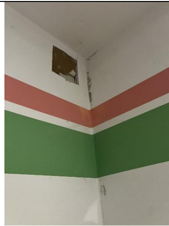
Abbildung 64: Feuchtigkeitsschaden (2/3)
