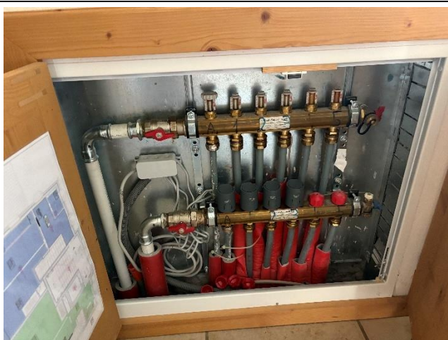
Abbildung 103: Verteilerkasten Fußbodenheizung
