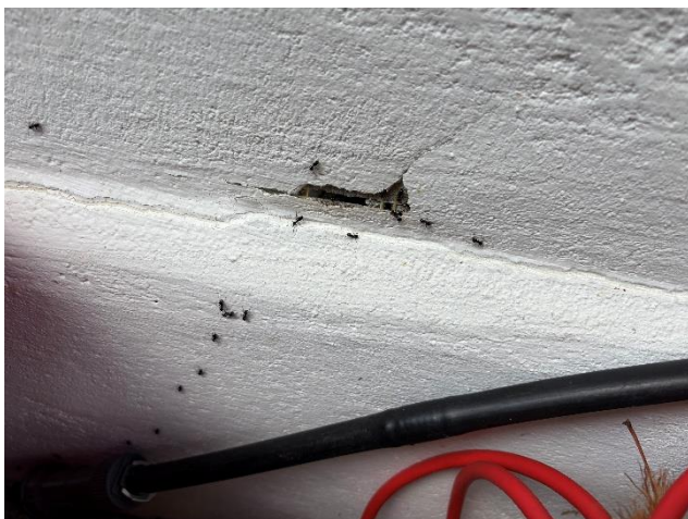
Abbildung 59: Riss Fassade
