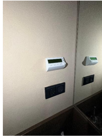
Abbildung 152: Raumthermostat (digital)
