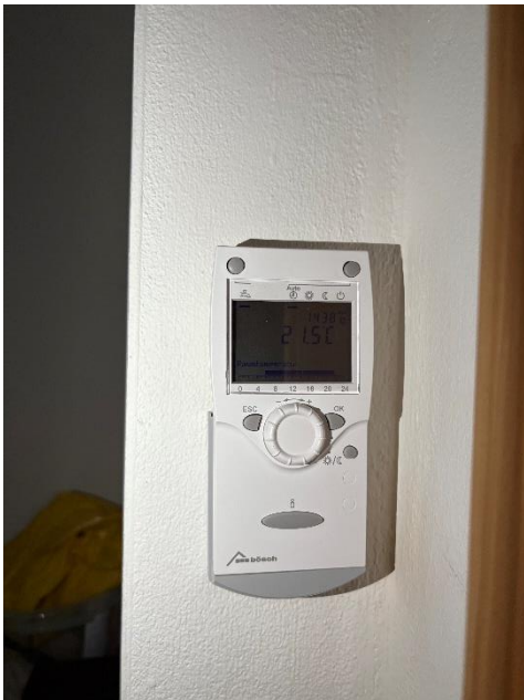
Abbildung 133: Raumthermostat (digital)
