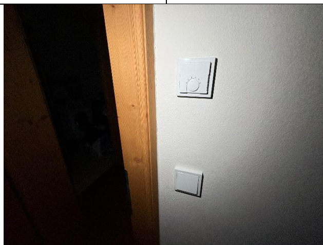
Abbildung 161: Raumthermostat (analog)
