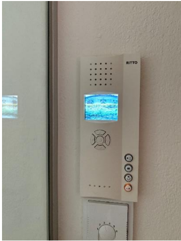
Abbildung 111: Gegensprechanlage
