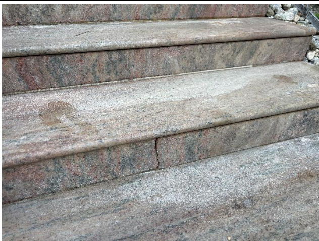
Abbildung 245: Riss Außentreppe
