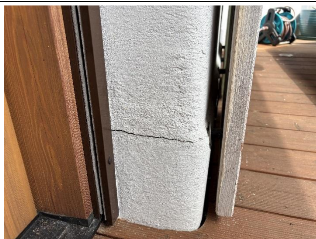
Abbildung 183: Riss Fassade
