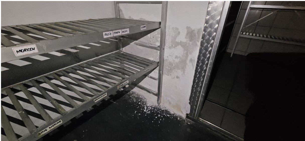
Abbildung 5 – Lebensmittellager – Wand zw. Kühlraum und Lagerraum
