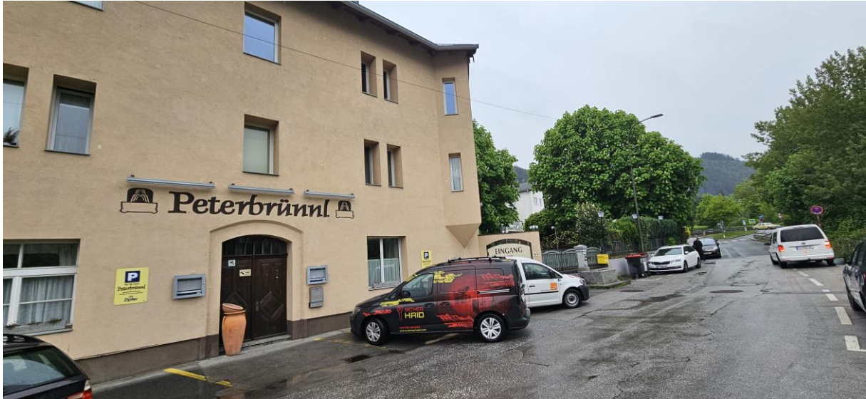
Abbildung 1 – Ansicht von der Straße
