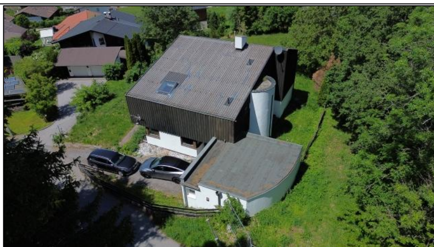
Blick von Nordost
