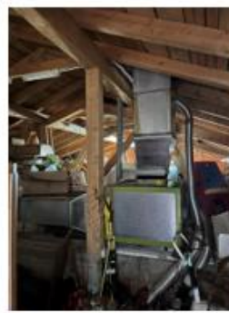
DG - Blick von Eingang
