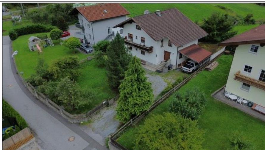
Blick von Nordosten
