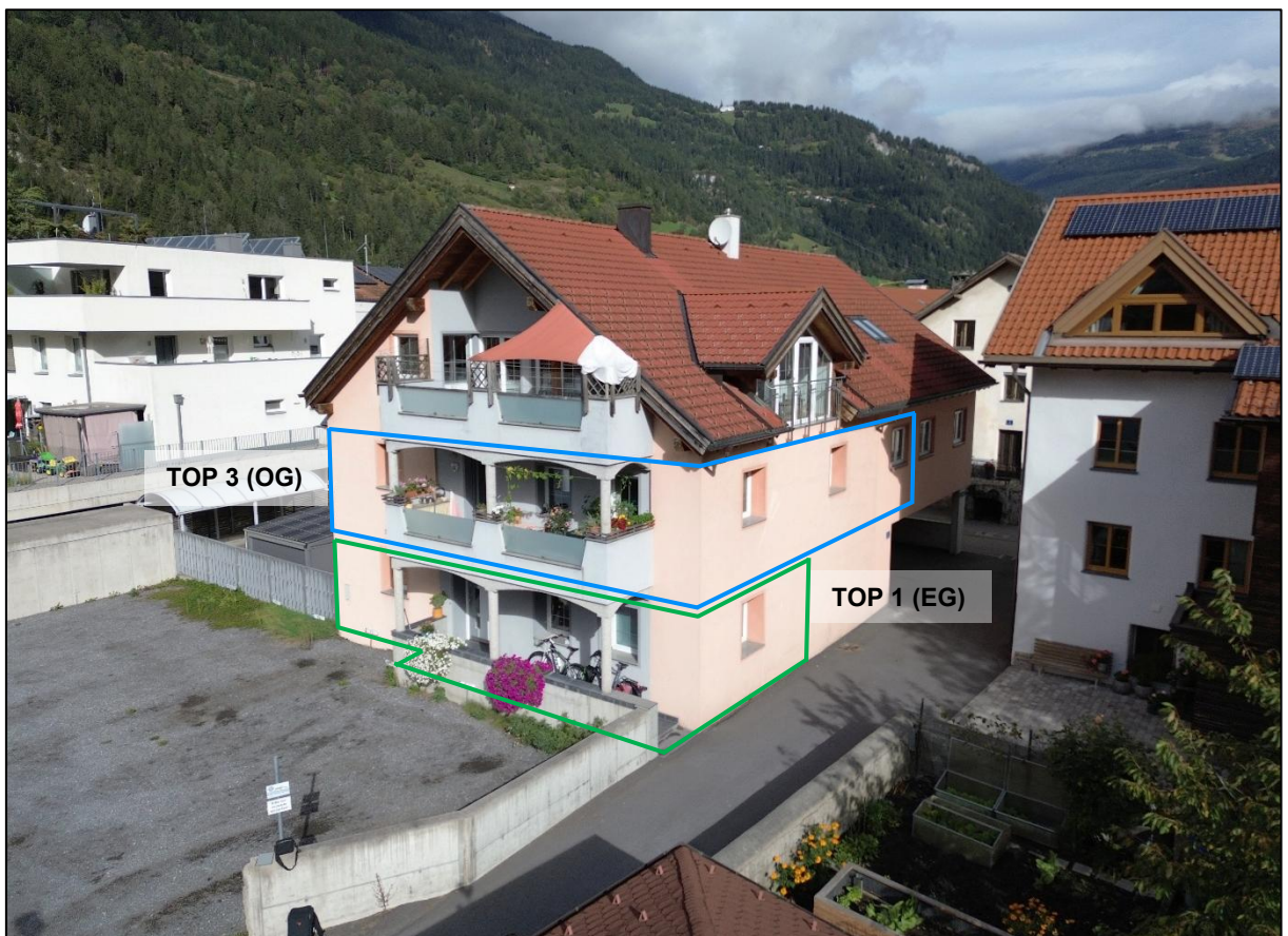
Südostansicht mit skizzenhafter Kennzeichnung der Wohnungen Top 1 (EG, grün) und Top 3 (OG, blau)
