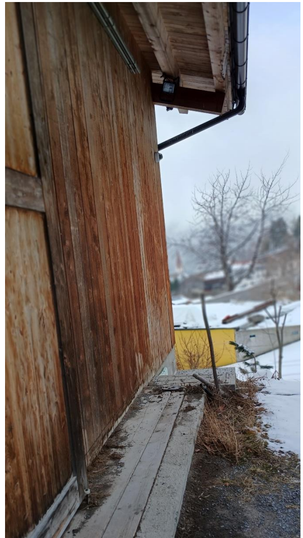
Abbildung 39: Östliche Ansicht Stadel
