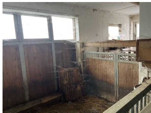
Abbildung 43: westliches Stallstor samt Buchten im Stall
