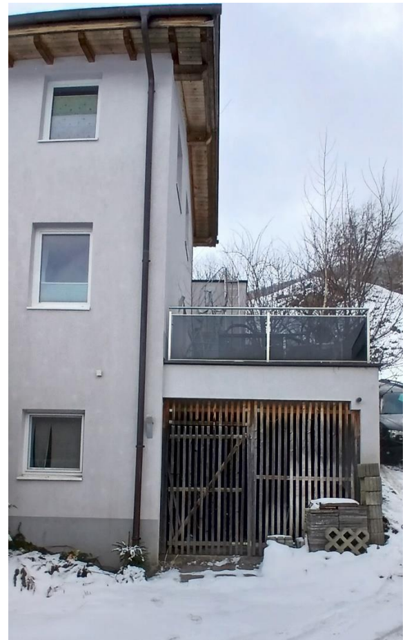
Abbildung 6: westl. Außenansicht samt Wegeflächen
