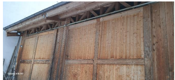
Abbildung 41: östliche Stadelfront samt Nachbargebäude
