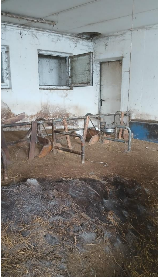
Abbildung 34: Stallinneres im Wirtschaftsgebäude: ehem. Kuhbett
