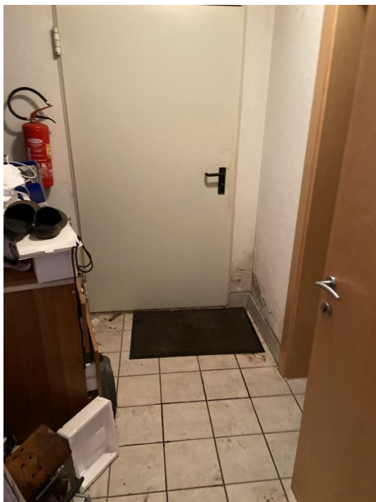
Abbildung 13: Vorraum im EG
