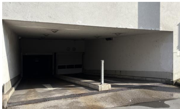
Abbildung 62: Ein- und Ausfahrt Tiefgarage
