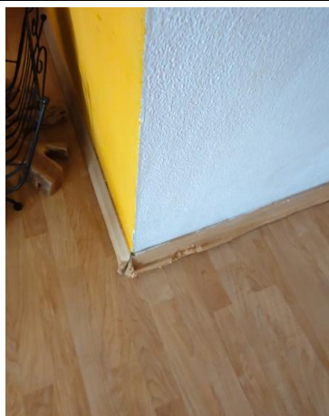
Abbildung 55: Beschädigte Fußbodenleisten
