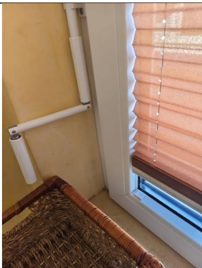
Abbildung 57: Detailbetrachtung im Bereich der Fenster
