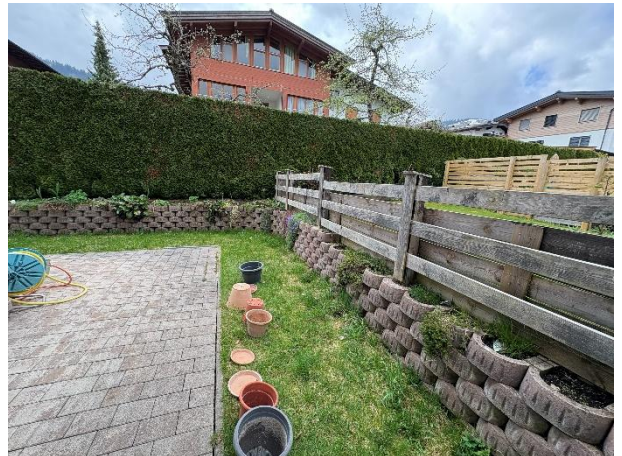
Abbildung 36: Garten mit Betonelementen wegen Böschung (1/4)
