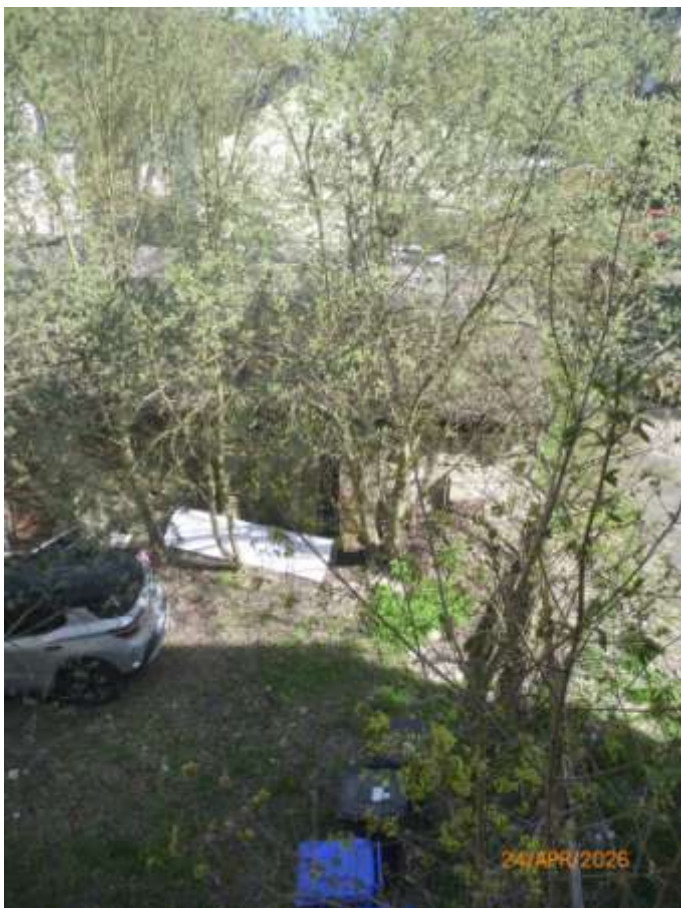
Bild 28: 2. Obergeschoss- Blick auf den hinteren Grund- stücksteil mit denkmalge- schütztem Nebengebäude
