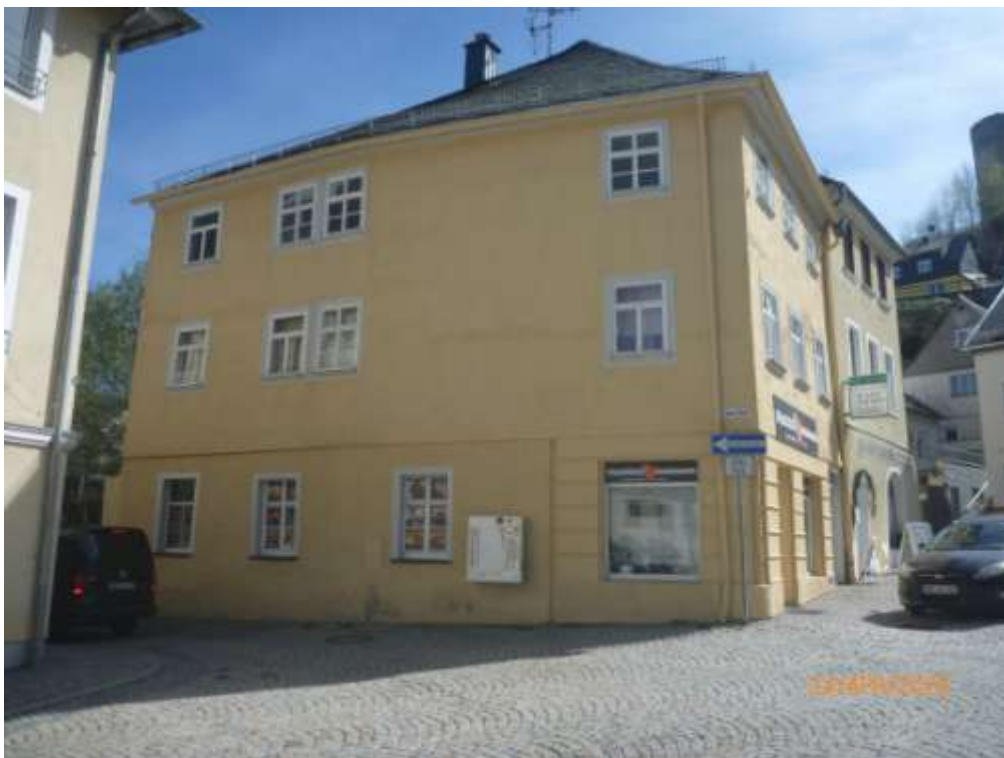
Bild 2: Seitenansicht zur Straße „Am Tor“
