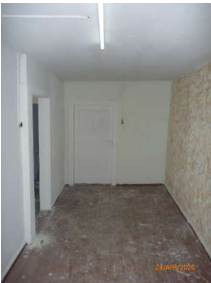
Bild 20: 2. Obergeschoss- Flur mit Zugang zu den Räumen
