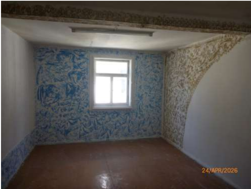
Bild 23: 2. Obergeschoss- zur Straße „Am Tor“ gelegener Raum
