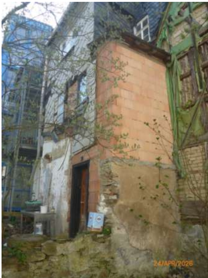
Bild 3: Hinteransicht des Versteigerungsobjektes von der Straße „Am Tor“; der nach Abbruch des angrenzenden Nachbargebäudes im Jahr 2006 angebrachte provisorische Schutz des Fachwerkes ist inzwischen verwittert
