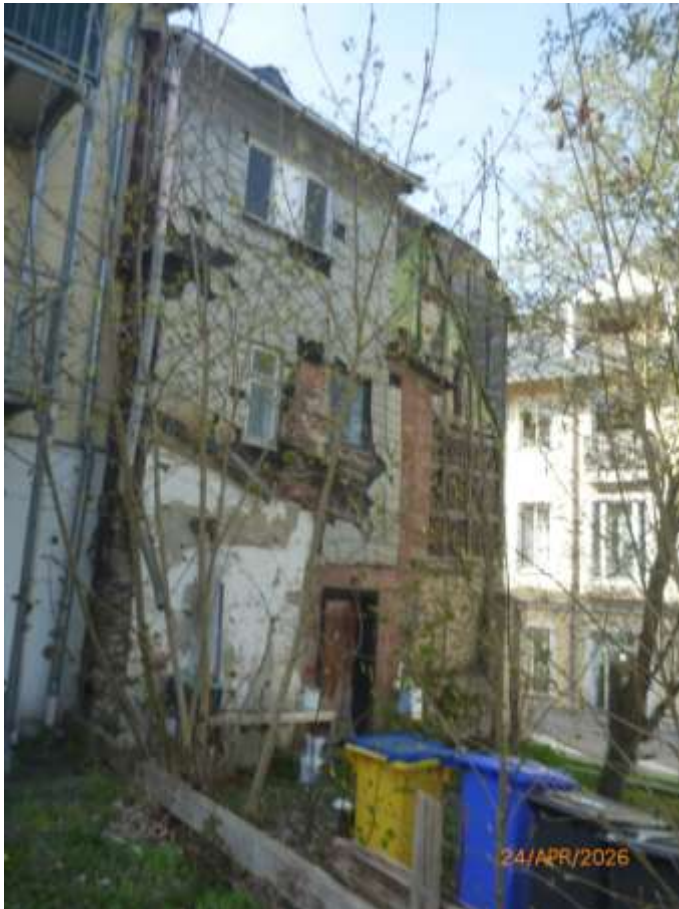
Bild 33: Hinteransicht des Wohn- und Geschäftshauses vom südlich angrenzenden Grundstück
