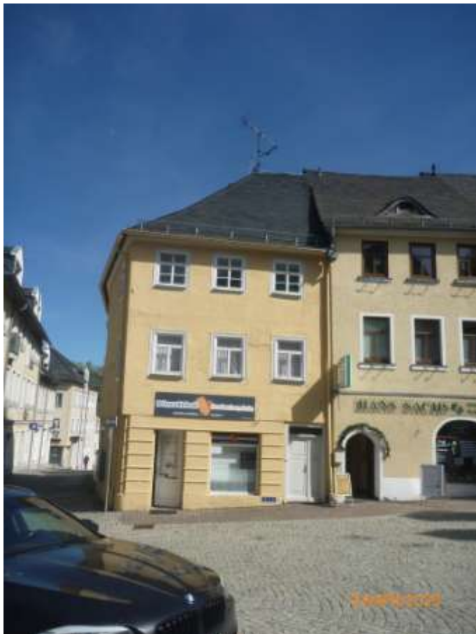
Bild 6: Gebäudefront zum Markt; links Zugang zum Imbiss, rechts Zugang zum Hausflur mit Treppe zu den Obergeschossen und Durchgang zum Hof
