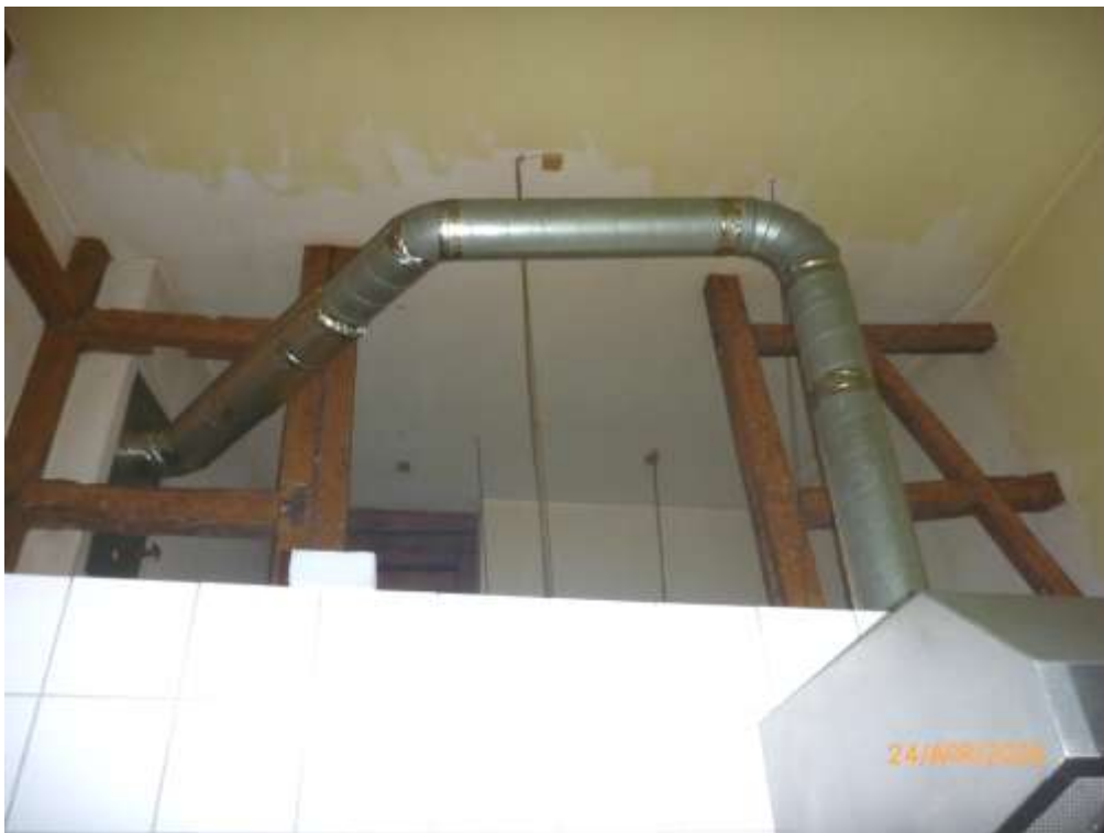
Bild 10: Erdgeschoss- über dem Küchenbereich wurde die Geschossdecke entfernt und eine Entlüftungsanlage für die Küche installiert
