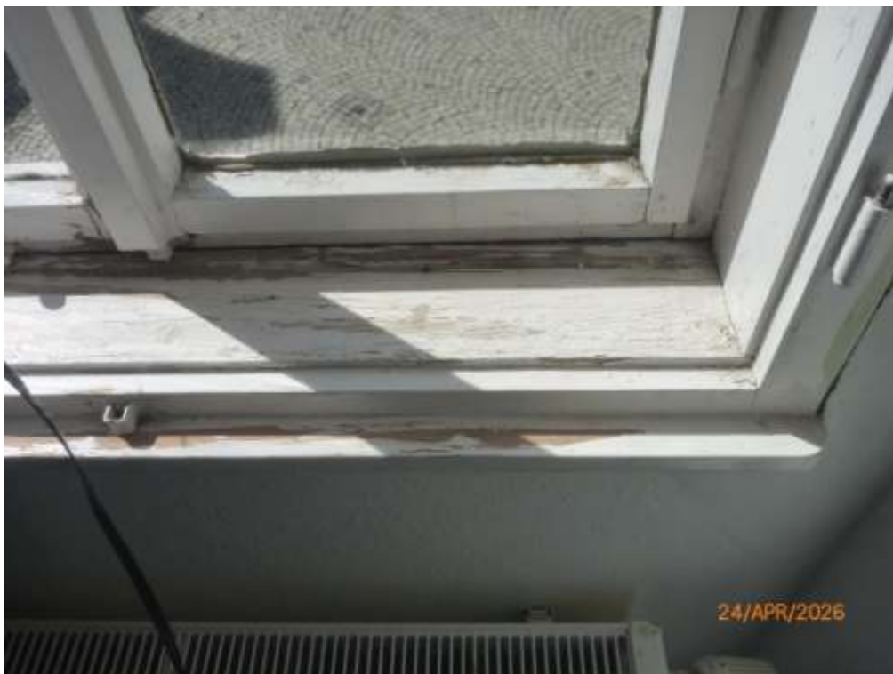
Bild 18: 1. Obergeschoss- im Gebäude sind überwiegend Kastenfenster aus Holz verbaut; die doppelten Fensterflügel waren nicht vorhanden
