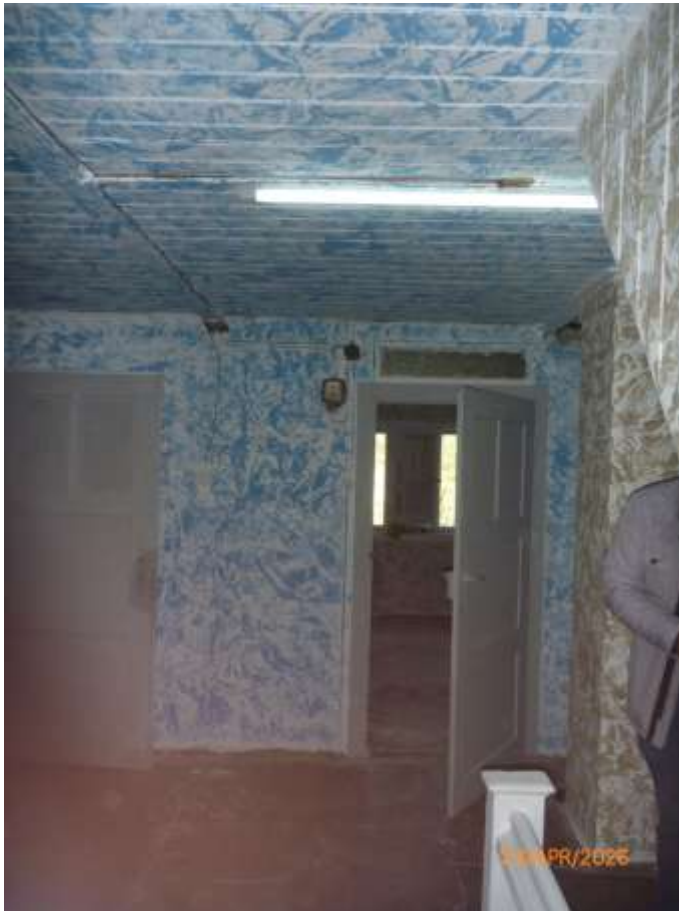
Bild 25: 2. Obergeschoss- Flur mit Treppe zum Boden und zum 1. Obergeschoss
