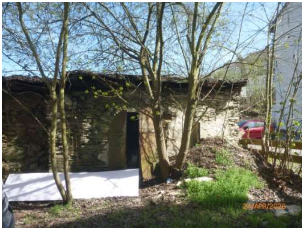
Bild 29: Hofansicht des denkmalgeschützten Nebengebäudes
