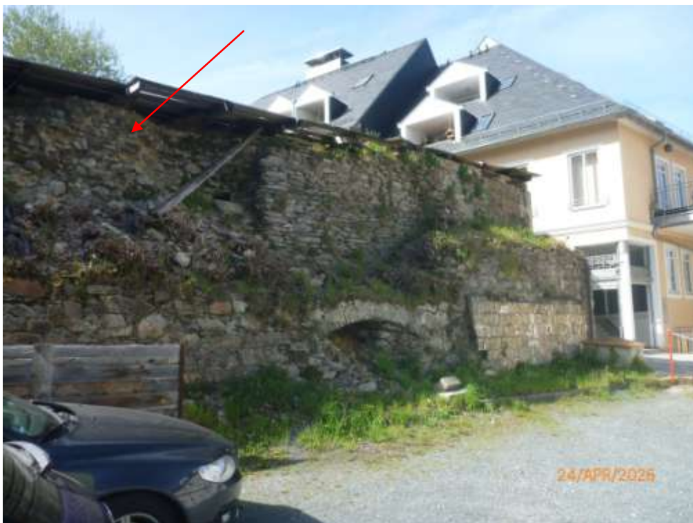
Bild 34: Ansicht des Restes der denkmalgeschützten ehemaligen Stadtmauer von Bad Lobenstein; auf einem Teil davon liegt das zum Versteigerungsobjekt gehörende Nebengebäude (s. Pfeil)
