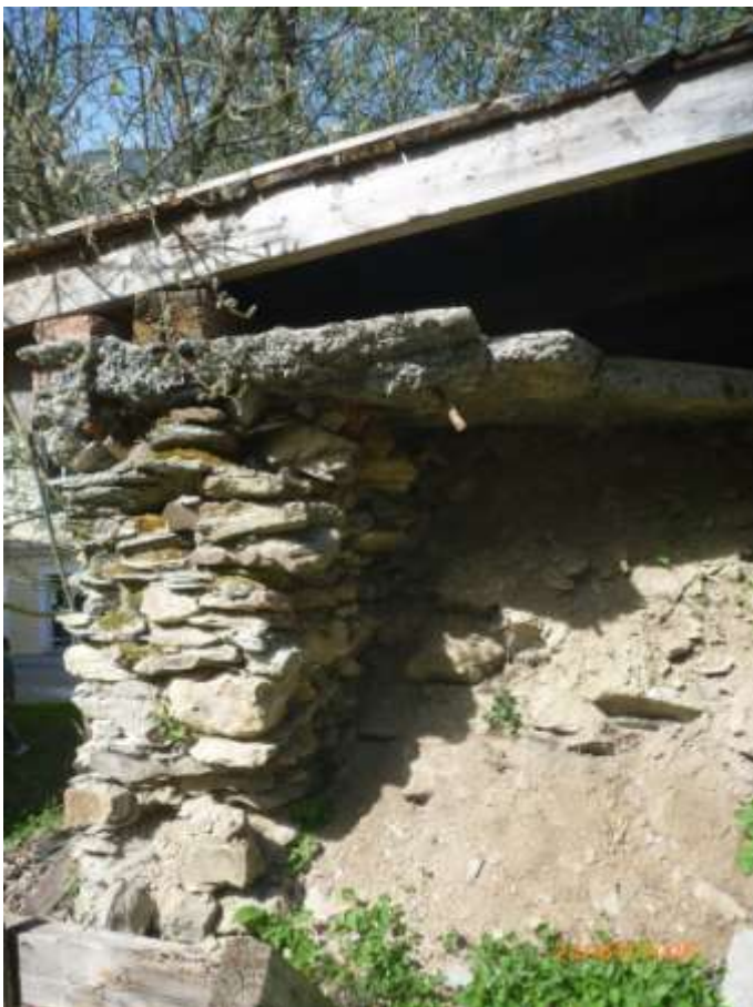
Bild 31: Ansicht des denkmalgeschützten Nebengebäudes vom südlich angrenzenden Nachbargrundstück; die Abstützung des zur Bauwerkssicherung errichteten Notdachs ist inzwischen tlw. eingebrochen
