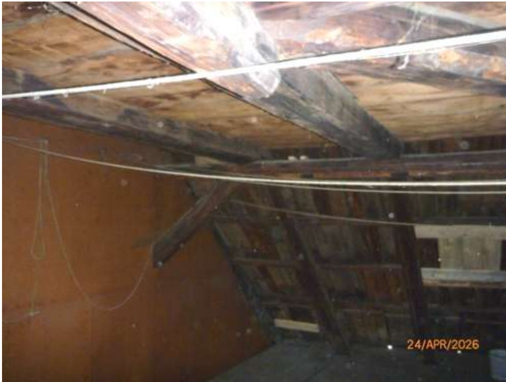
Bild 27: Dachboden- nicht ausgebaut
