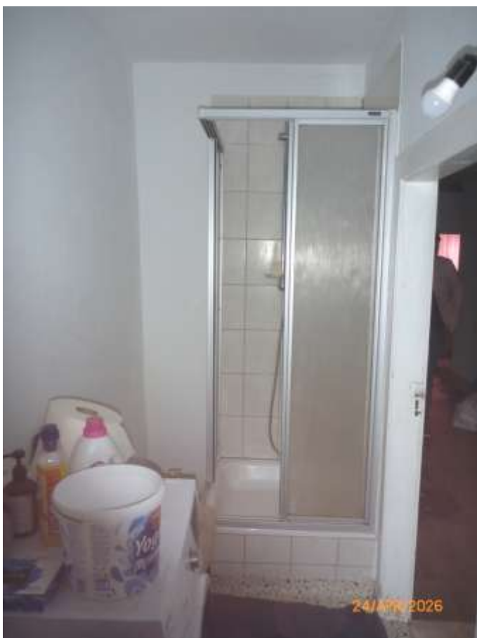
Bild 16: 1. Obergeschoss- Dusche im Bad mit Zugang vom Flur
