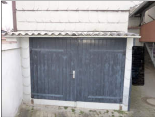
Foto 21: Anbau - ehemals als Garage genutzt – hofseitige Vorderansicht
