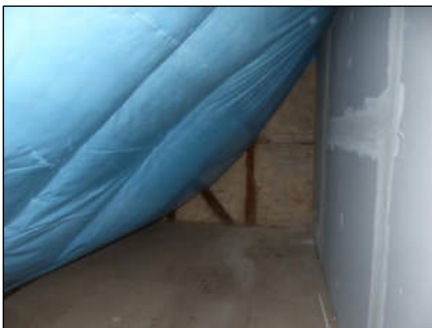
Foto 17: DG – Dachboden als exemplarische Ansicht
