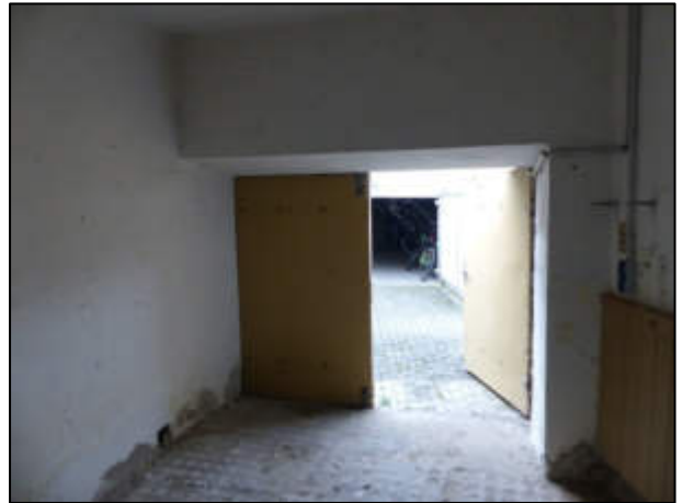
Foto 22: Anbau - ehemals als Garage genutzt – Innenansicht
