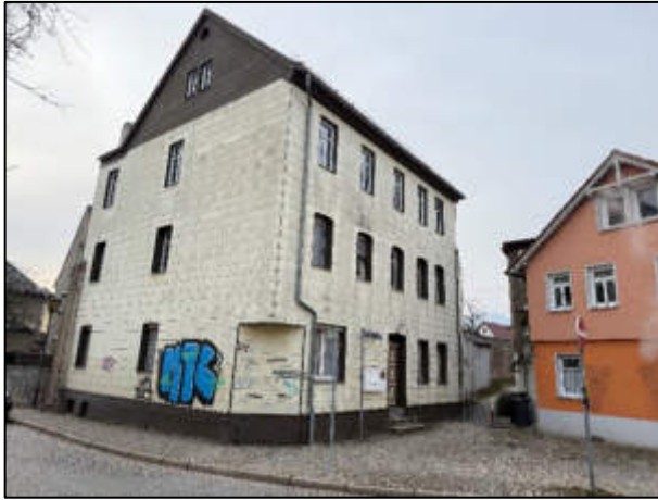
Foto 01: Straßenseitige Vorderansicht von links Nord-Ost-Ansicht
