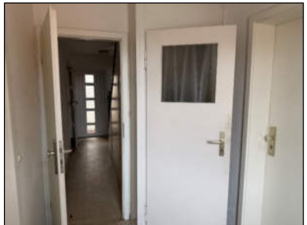
Foto 10: 1. OG – Treppenabsatz mit Zugang zu den WE 3, 4 und 5
