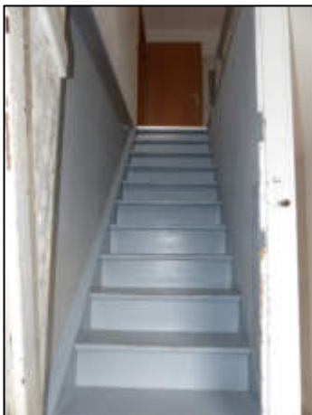
Foto 15: DG – WE 5 – interne Treppe zu den Wohnräumen im Dachgeschoss (DG)
