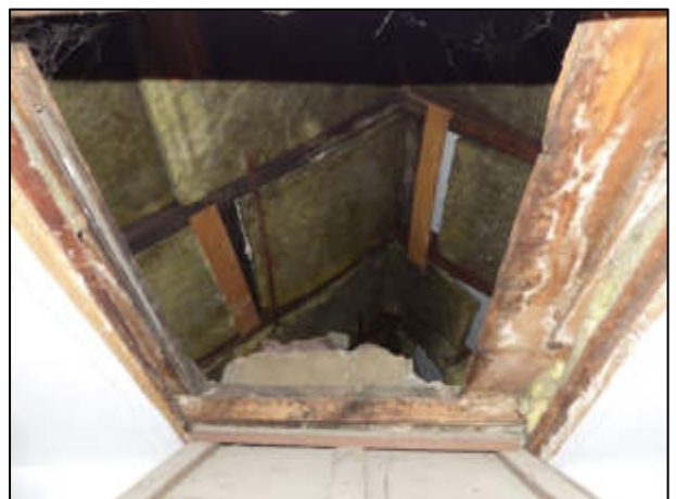
Foto 18: DG – Blick in den Spitzboden
