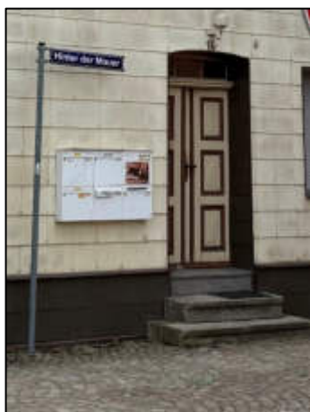
Foto 05: Straßenseitiger Hauseingangsbereich auf der Gebäudevorderseite
