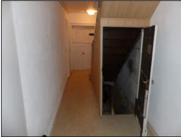
Foto 07: Erdgeschoss (EG) – Hausflur mit Treppe zum Obergeschoss (OG) und Zugang zur Teilunterkellerung
