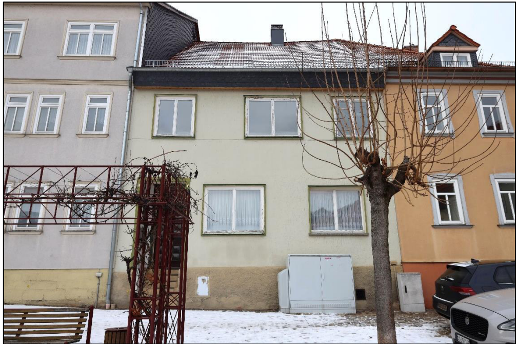
Ostansicht – Einfamilienwohnhaus / Reihen- mittelhaus
