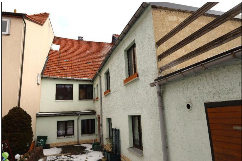
Westansicht – Einfamilienwohnhaus / Reihen- mittelhaus mit Anbau
