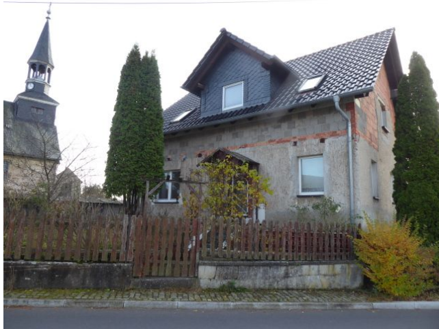
Nord - Ost - Ansicht Foto 1
