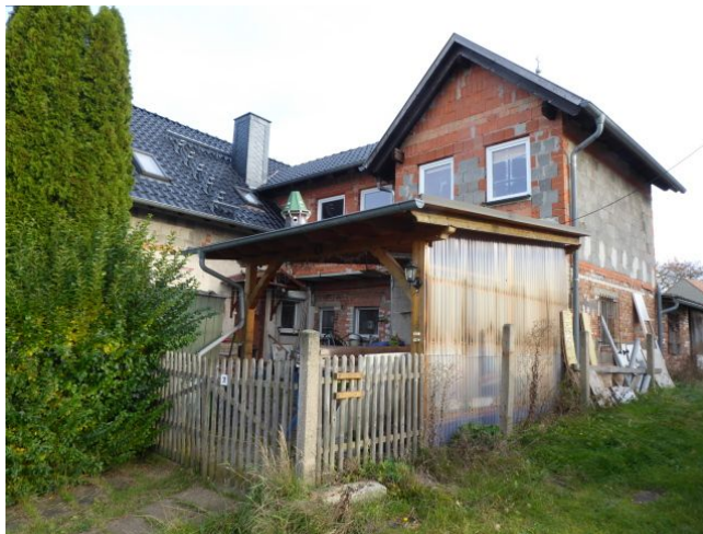
Westlicher Anbau mit Überdachung Foto 3
