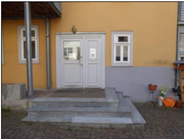
Bild 03: Zugang zur Immobilie über den Hauseingang Kirchgasse 7
