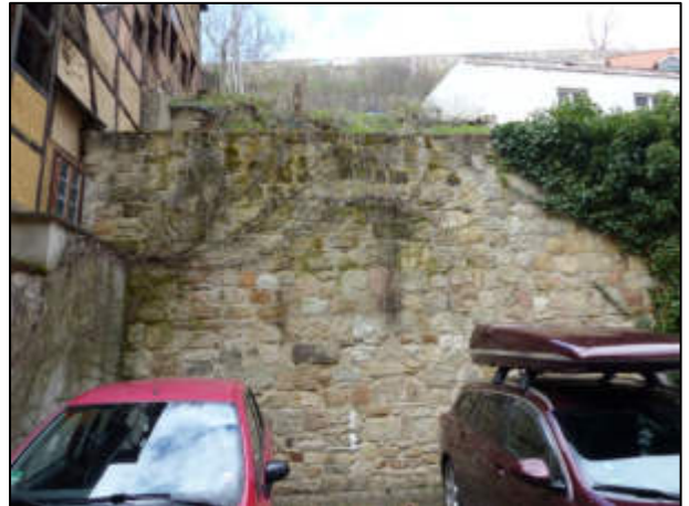
Bild 08: Außenanlagen - Sandsteinmauer zur Hangsicherung
