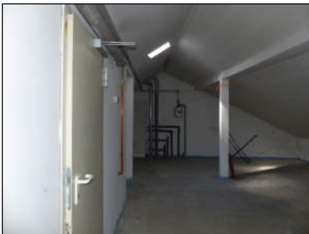
Bild 05: Dachgeschoss Nicht wohnwirtschaftlich ausgebaut
