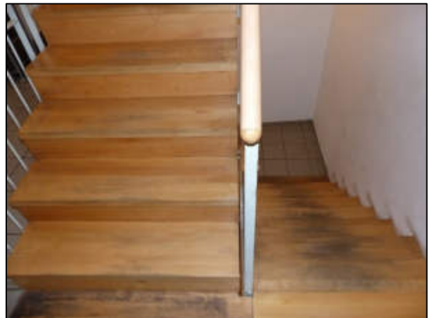
Bild 04: Gemeinsam genutztes Treppenhaus für Kirchgasse 5/7 im Gebäude Kirchgasse 7 - exemplarische Ansicht
