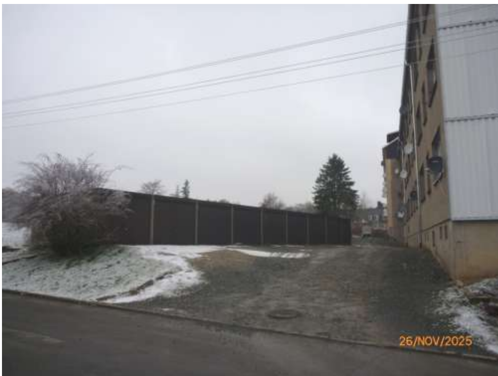
Bild 12: unbefestigter Zugang / Zufahrt auf der Gebäuderückseite zu der Reihen- garagenanlage
