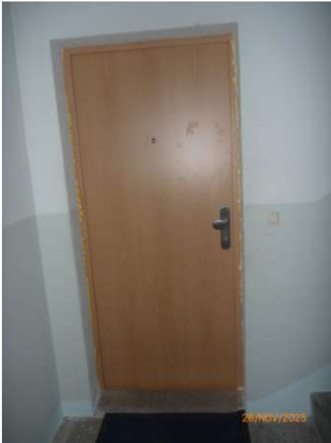
Bild 5: Treppenhaus mit Wohnungseingangstür zur WE-Nr. 30 im 2. Obergeschoss
