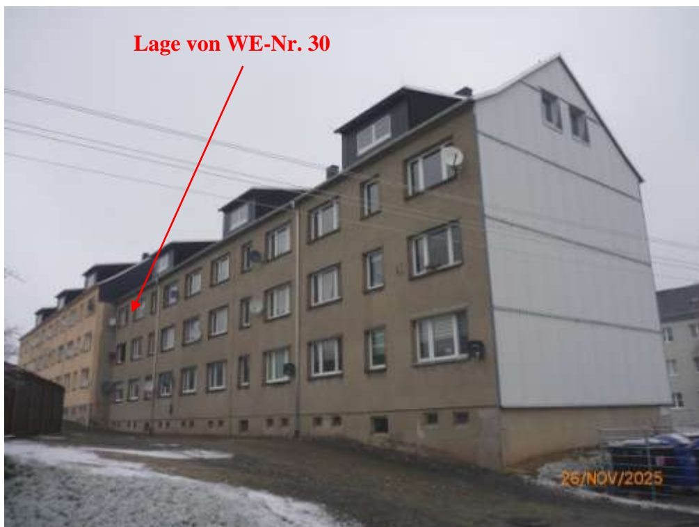
Bild 2: Hinteransicht des Gebäudekomplexes von der Friedrich-Wolf-Straße; die WE-Nr. 30 befindet sich im 2. Obergeschoss des vorderen Gebäudeteiles, angrenzend an den hinteren Gebäudeteil
