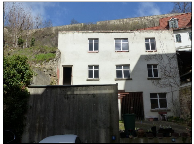
Nebengebäude (nicht ausgebaut)
