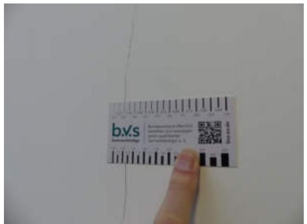
Bild 12: Baumängel/Bauschäden Wandriss im Treppenhaus (exemplarisch), Rissbreite 0,2 mm
