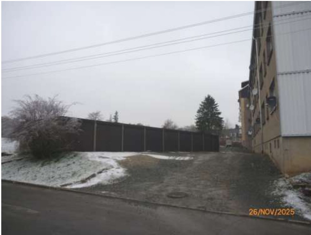
Bild 11: unbefestigter Zugang / Zufahrt auf der Gebäuderückseite zu der Reihengaragenanlage
