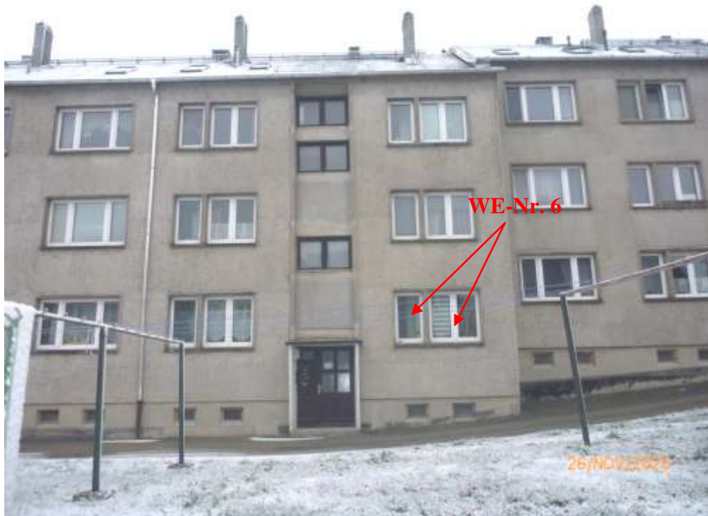
Bild 3: Hauseingang Nr. 31 im vorderen Gebäudeteil; Holzrahmentür mit Brief-Kastenanlage und Wechselsprechanlage; zur WE-Nr. 6 gehörende Bad- und Küchenfenster (s. Pfeil)
