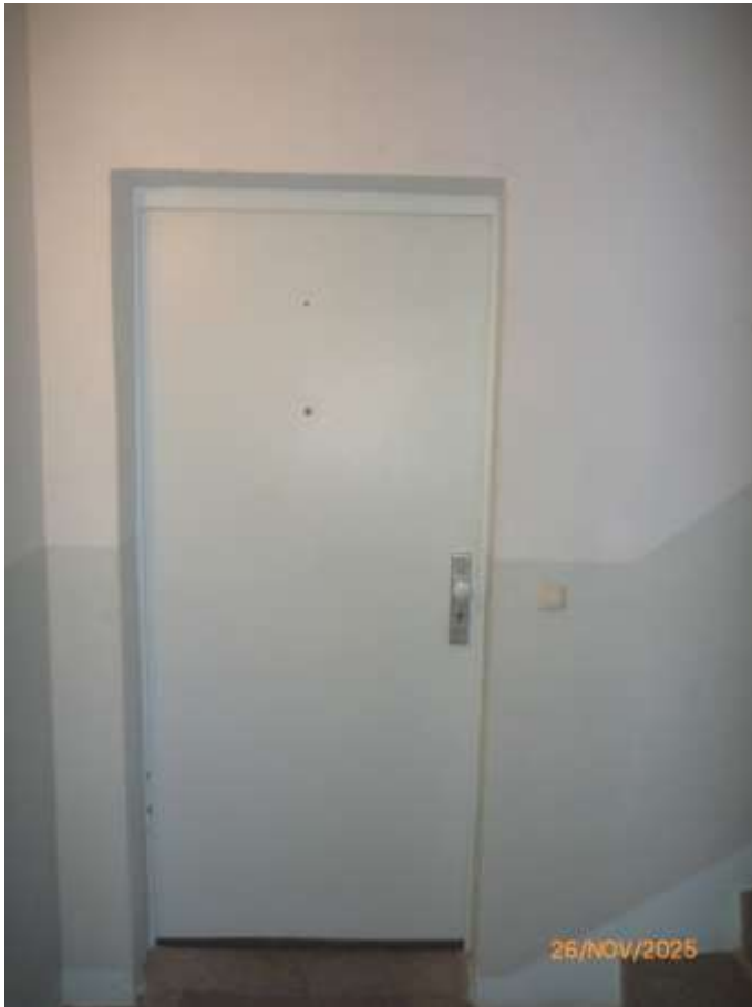
Bild 5: Treppenhaus mit Wohnungseingangstür zur WE-Nr. 6 im Erdgeschoss
