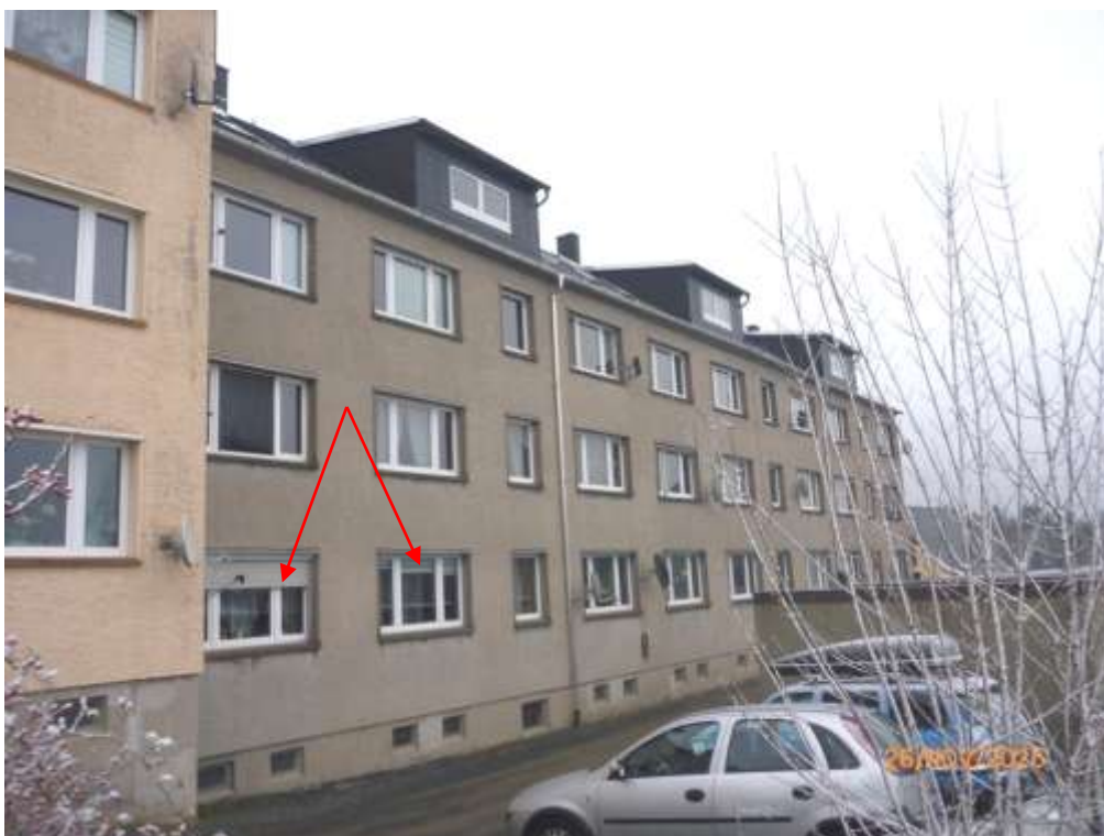
Bild 12: Gebäuderückseite nach Südwesten mit Lage von Wohn- und Schlafräum der WE-Nr. 6 (s. Pfeil)
