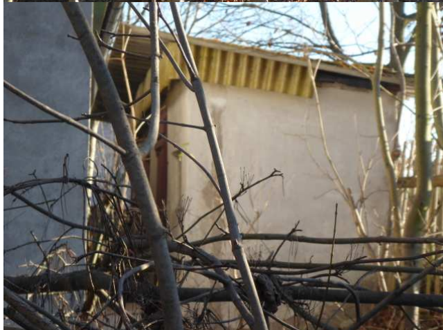
Schuppen an westlicher Grundstücksgrenze Foto 4
