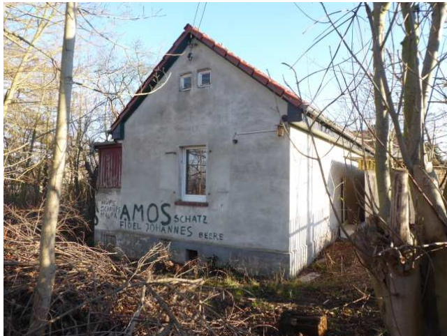
Nord - West - Ansicht Foto 2
