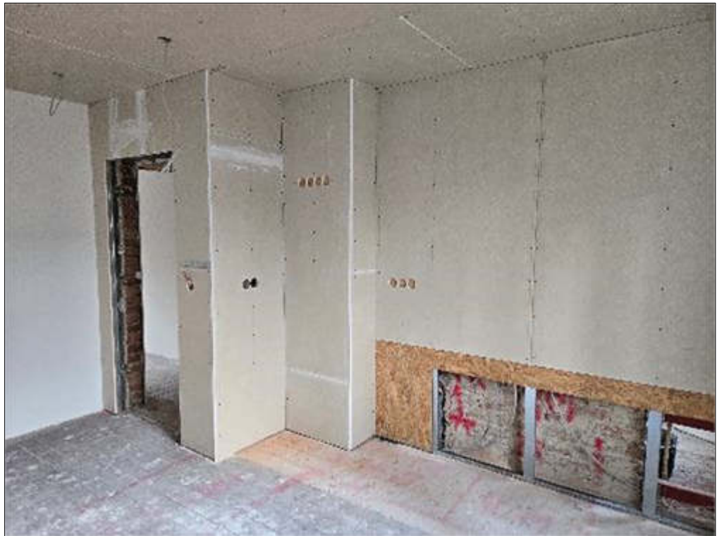
Bild 13 Pos. 01 Wohnhaus, innen, SE 1, Küche
