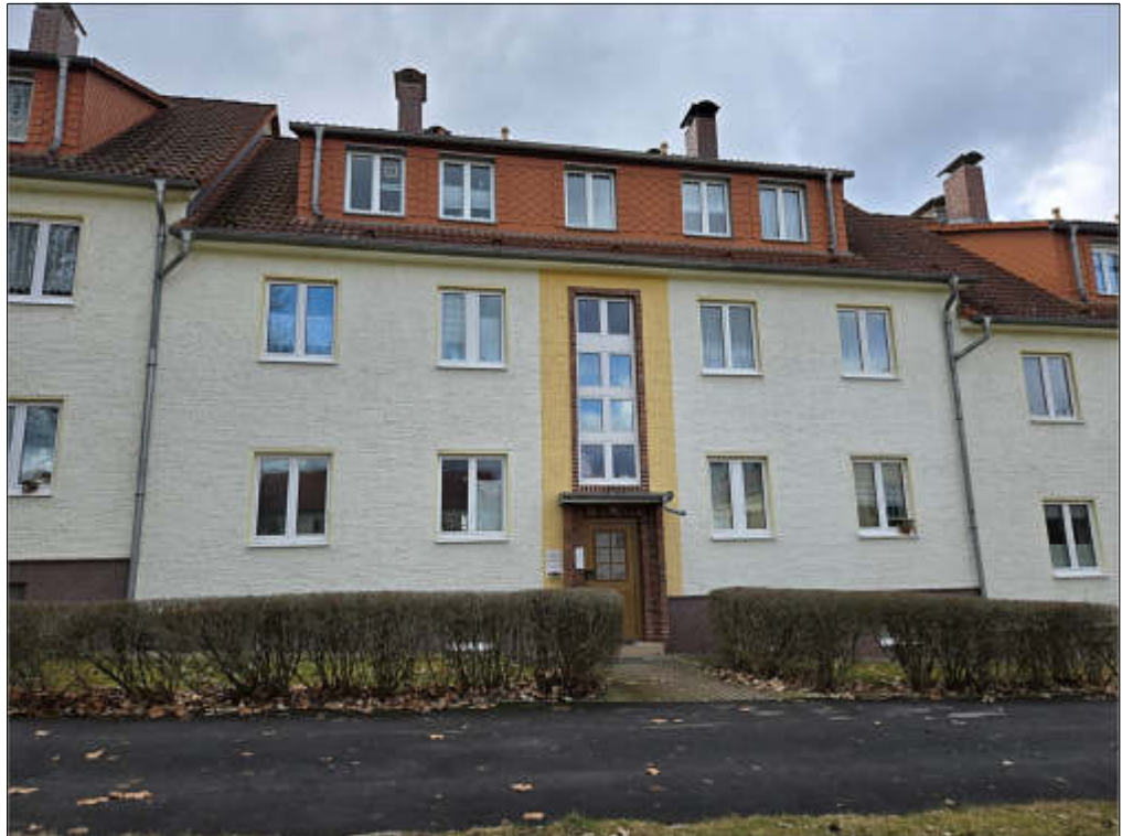
Bild 1 Pos. 01 Wohnhaus, Gesamtgebäude, Ostseite
