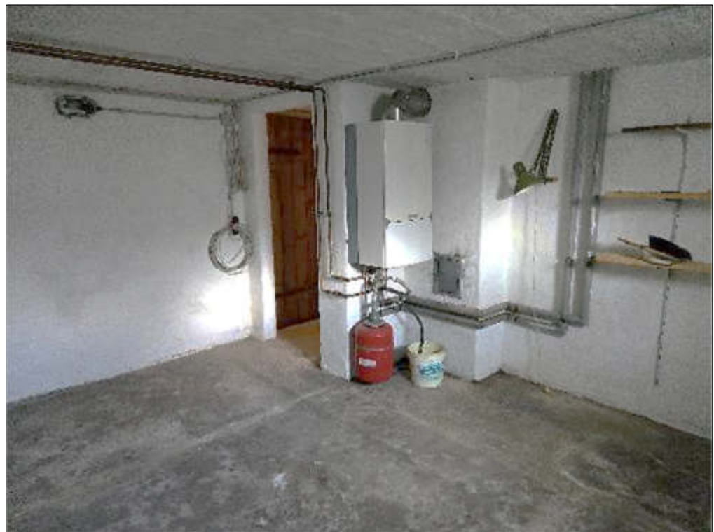
Bild 16 Pos. 01 Wohnhaus, innen, SE 1, Keller
