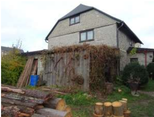
Flurstück 149/2 - Einfamilienhaus mit Lageranbau
