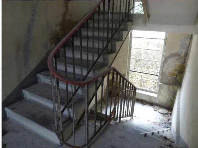
Treppenhaus Hintergebäude Foto 6
