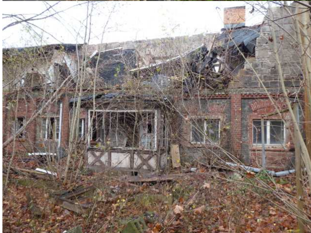
westliches Nebengebäude Blick vom Hof Foto 3
