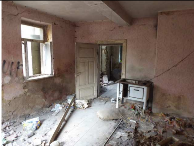
Sockelgeschoß Vordergebäude Foto 5
