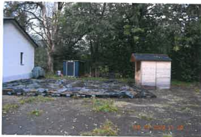
Ansicht des provisorischen Terrassenunterbaus
