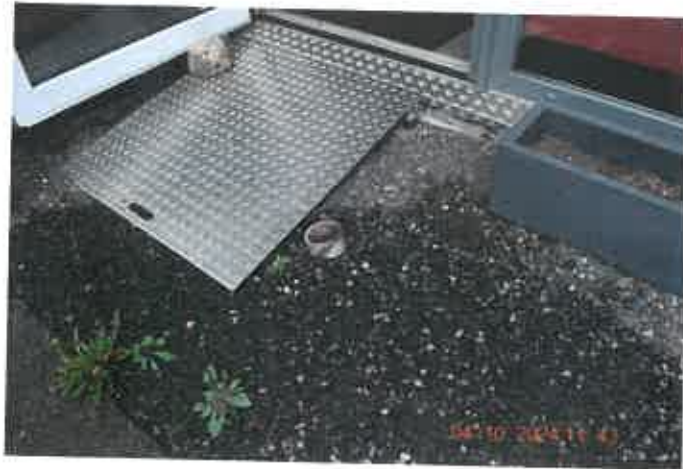
provisorische Überbrückung der Höhendifferenz Eingangsbereich
