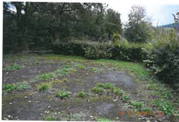
Ansicht restliche Freifläche (alter Bitumenbelag)
