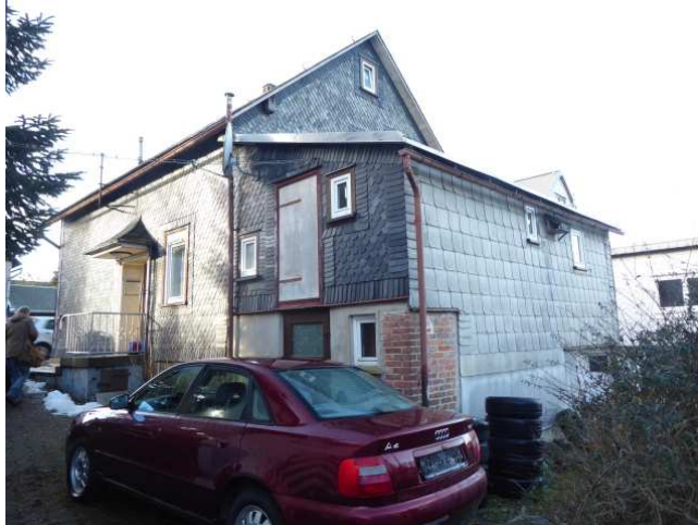
Nord - Ost - Ansicht Foto 3
