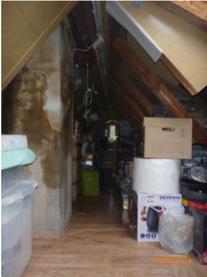
Bild 17: Dachboden im Bereich des 1936 errichteten Wohngebäudes
