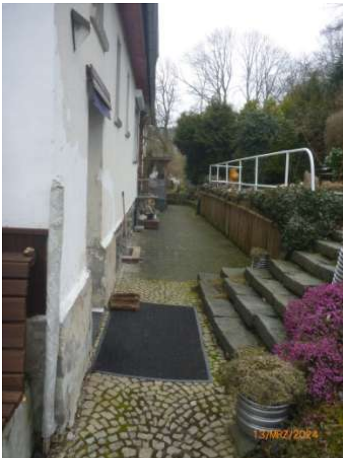
Bild 4: Süd- bzw. hintere Traufseite des Wohngebäudes mit Zugang zum Keller; rechts am ehemaligen Standort der Scheune wurde eine Terrasse errichtet
