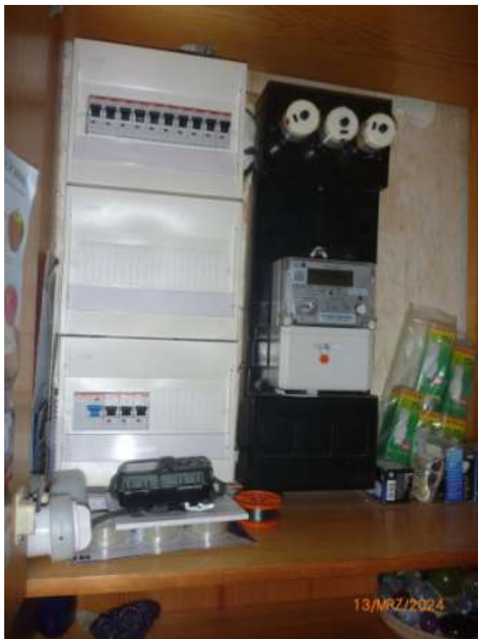
Bild 16: tlw. erneuerte Elektrover- teilung im Flur der Wohn- räume im Ober- bzw. Dachgeschoss
