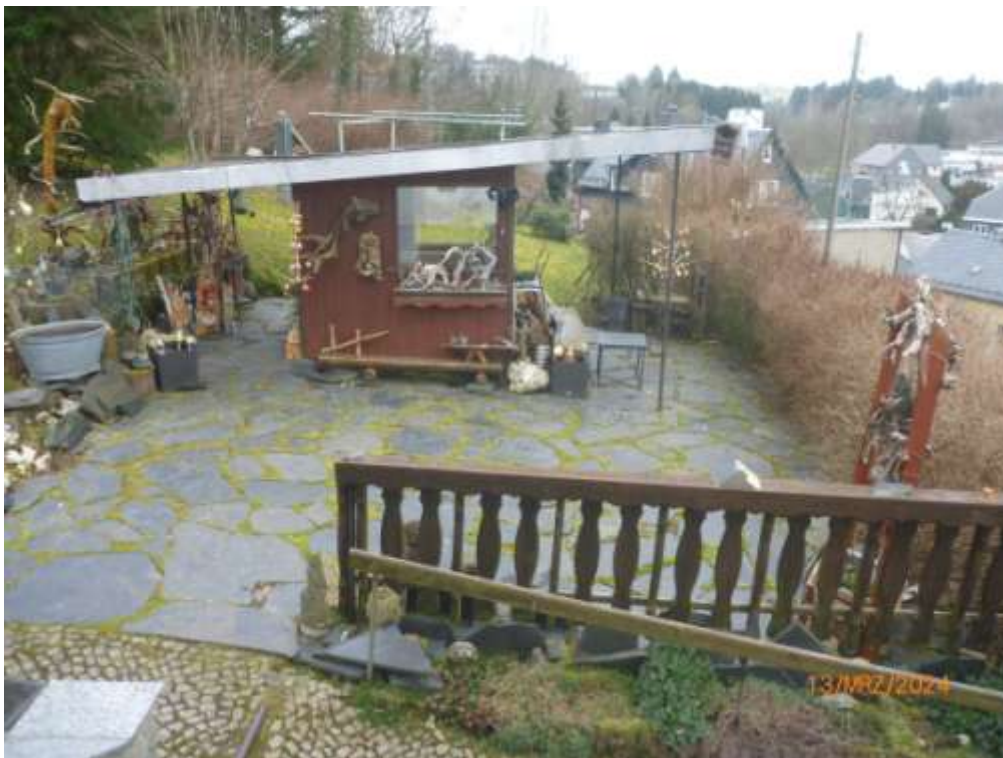
Bild 20: westlich vor dem Wohngebäude errichtete Terrasse mit dem ehemaligen Kiosk als Gartenlaube (Nebengebäude-II)
