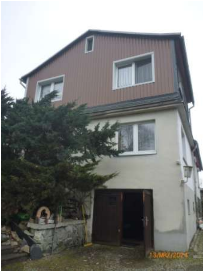
Bild 3: Ostansicht des Wohngebäudes mit dem 1960/75 erfolgten Anbau
