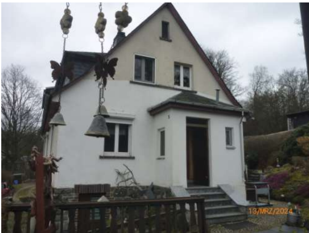
Bild 2: Westansicht des Wohngebäudes mit Hauseingang und vorgebautem Windfang
