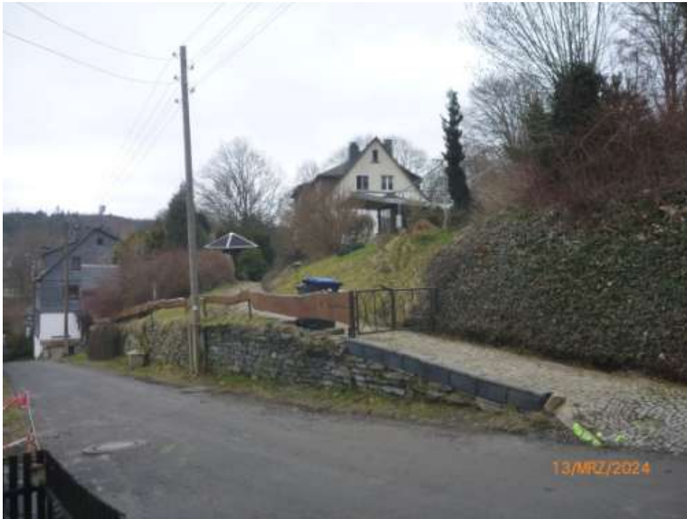
Bild 1: Westansicht des Bewertungsobjektes mit Zugang vom Haslersbergweg; die Stützmauer gehört nach Auskunft der Eigentümer zum Grundstück
