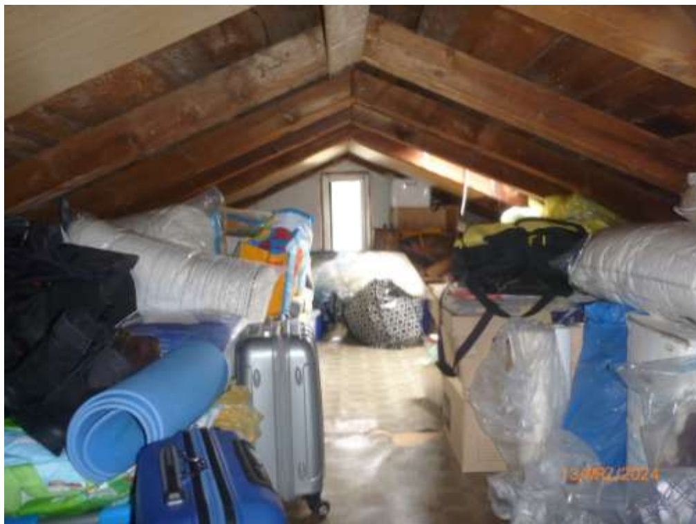
Bild 18: Dachboden im Bereich des 1960/75 erfolgten Wohngebäudeanbaus
