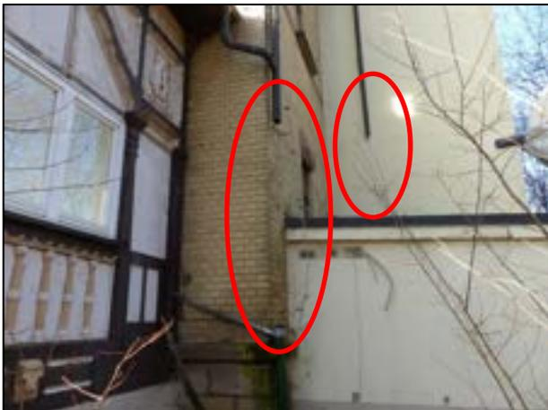
Foto 31: BoG<sup>6</sup> - fehlende Regenwasserfallrohre an sämtlichen Fallrohren
