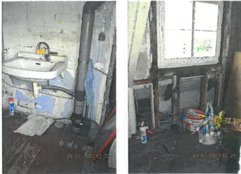
unsanierter Raum Dachgeschoss
