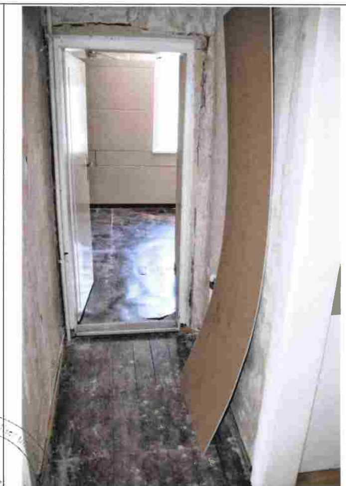
Wohnhaus Dachgeschoss Flur
