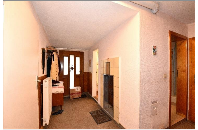
Einfamilienhaus mit Einliegerwohnung, Erdgeschoss, Eingangsflur Südwest mit Warmluftofenheizung und Tür zum Bad (rechts)
