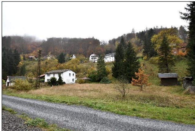
Ostansicht mit Wohngrundstück und Garage (links), darüberliegendes Hanggrundstück, Flurstücks 64/4 und Flurstück 65/6 im Vordergrund
