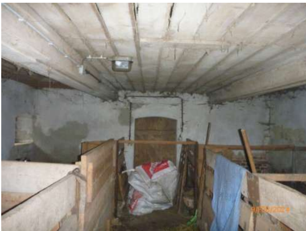
Bild 28: Nebengebäude-III; der Stallteil auf der nordöstlichen Giebelseite hat eine unverkleidete Holzdecke
