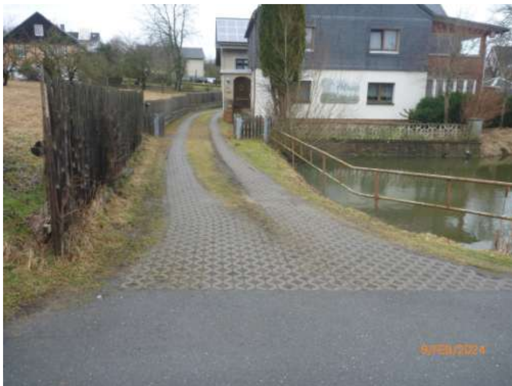
Bild 40: als Baulast auf dem Bewertungsobjekt gesicherte Zufahrt von der öffentlich gewidmeten Ortsstraße zum Flurstück-Nr. 143/2 im Hintergrund
