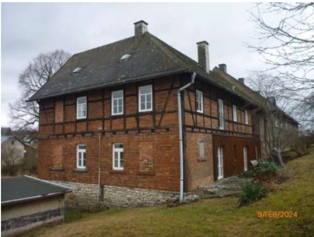
Bild 2: Süd- bzw. Hinteransicht des Wohngebäudes-I mit dahinter angebautem Wohngebäude-II; vor den Ferienwohnungen im Erdgeschoss ist mit der Errichtung einer Terrasse begonnen worden
