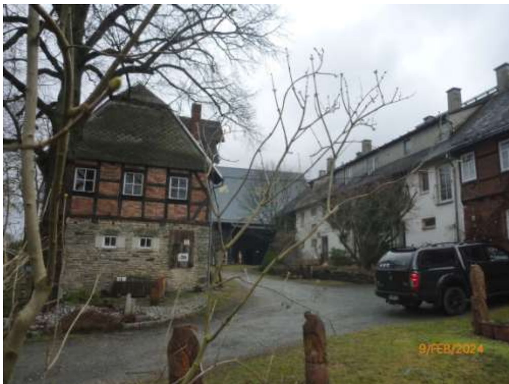
Bild 38: Ansicht des Innenhofes aus südlicher Richtung mit Wohngebäude-I und anschließendem Wohngebäude-II, links das Nebengebäude-III, im Hintergrund die Scheune-IV
