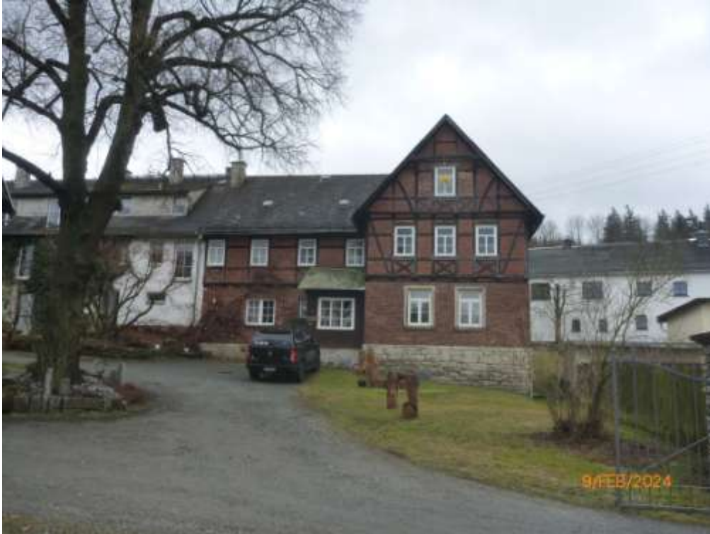
Bild 1: Nordwestansicht des Beschlagnahmeobjektes mit Wohngebäude-I und zum Wohngebäude-II umgebauten ehemaligen seitlichen Stallanbau
