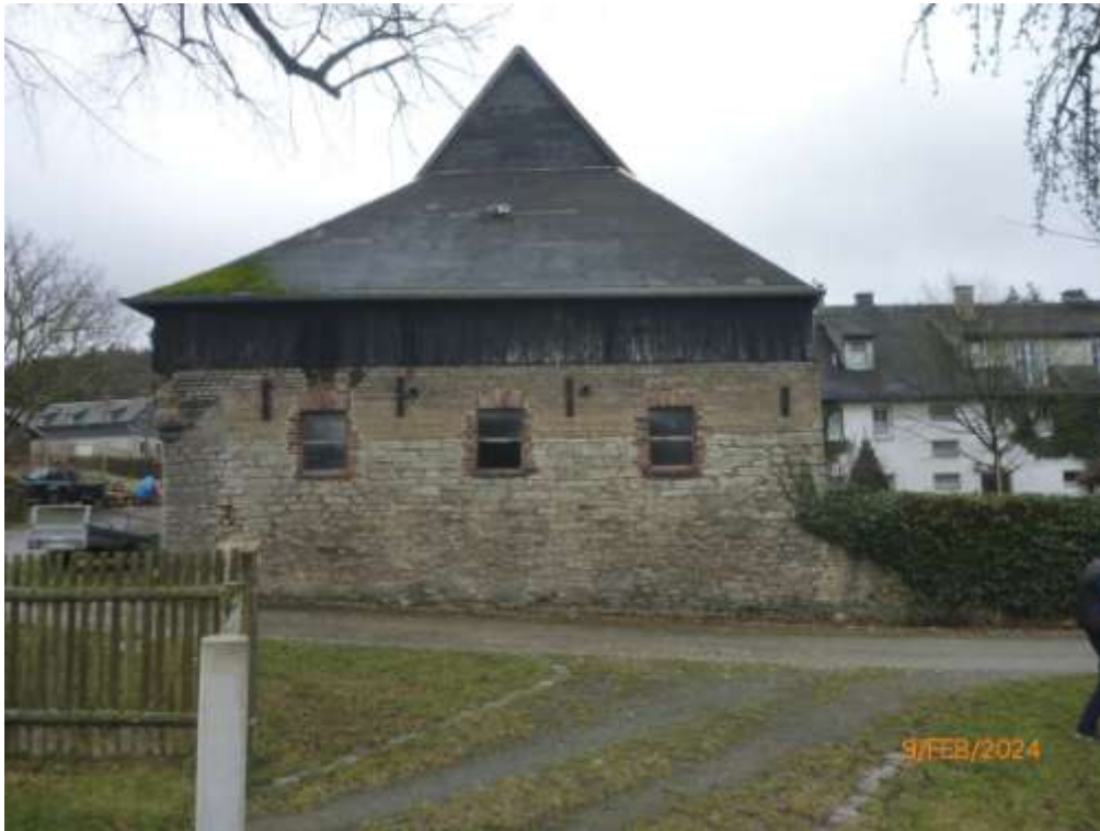
Bild 35: Ansicht des massiven Seitenanbaus am Nordwestgiebel der Scheune-IV; rechts im Hintergrund das Wohngebäude-II
