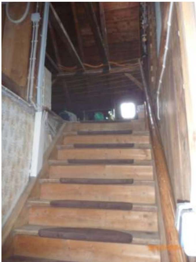
Bild 12: Wohngebäude-I; Treppe zu Dachboden
