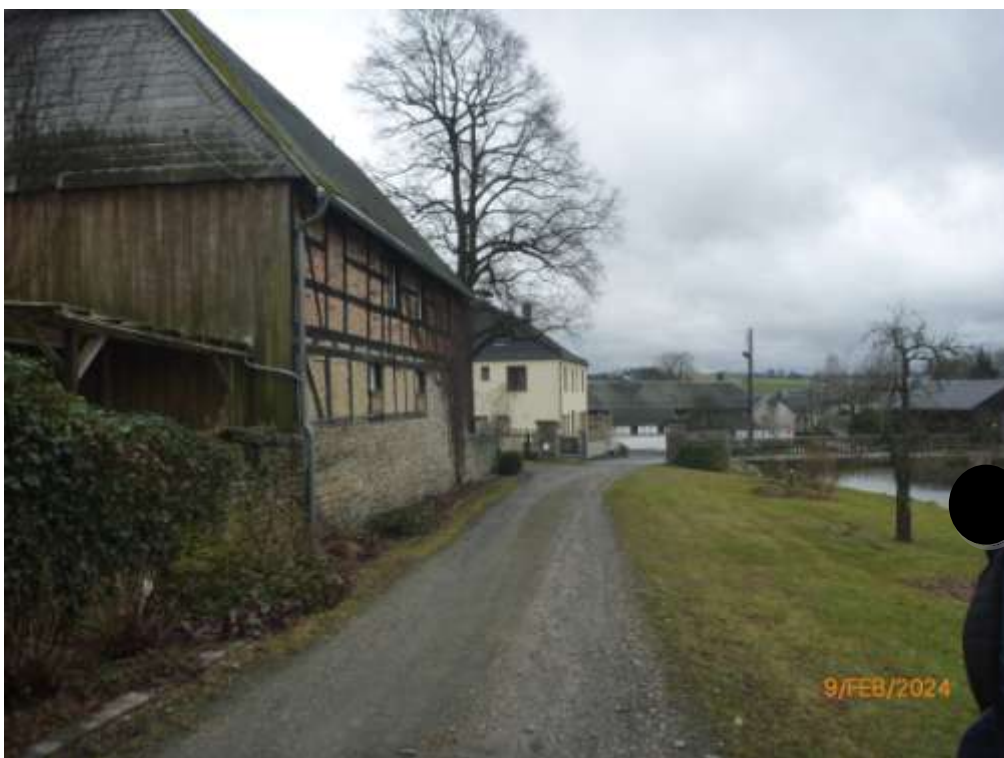
Bild 36: Blick von der Scheune-IV in südwestliche Richtung; links des zum Bewertungsobjekt gehörenden Weges das Nebengebäude-III, rechts die Wiese und dahinter der Teich
