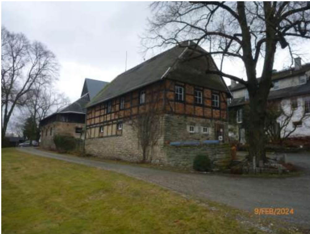
Bild 37: entlang des Nebengebäudes-III und der Scheune führt ein lose befestigter Weg, der auch als Zuwegung zum dahinter liegenden Wohngrundstück genutzt wird (mit Geh- und Fahrrecht im Grundbuch gesichert)
