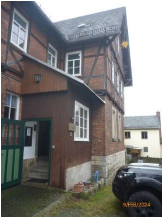
Bild 3: Wohngebäude-I; Hauseingang mit nach- träglich vorgebautem Windfang
