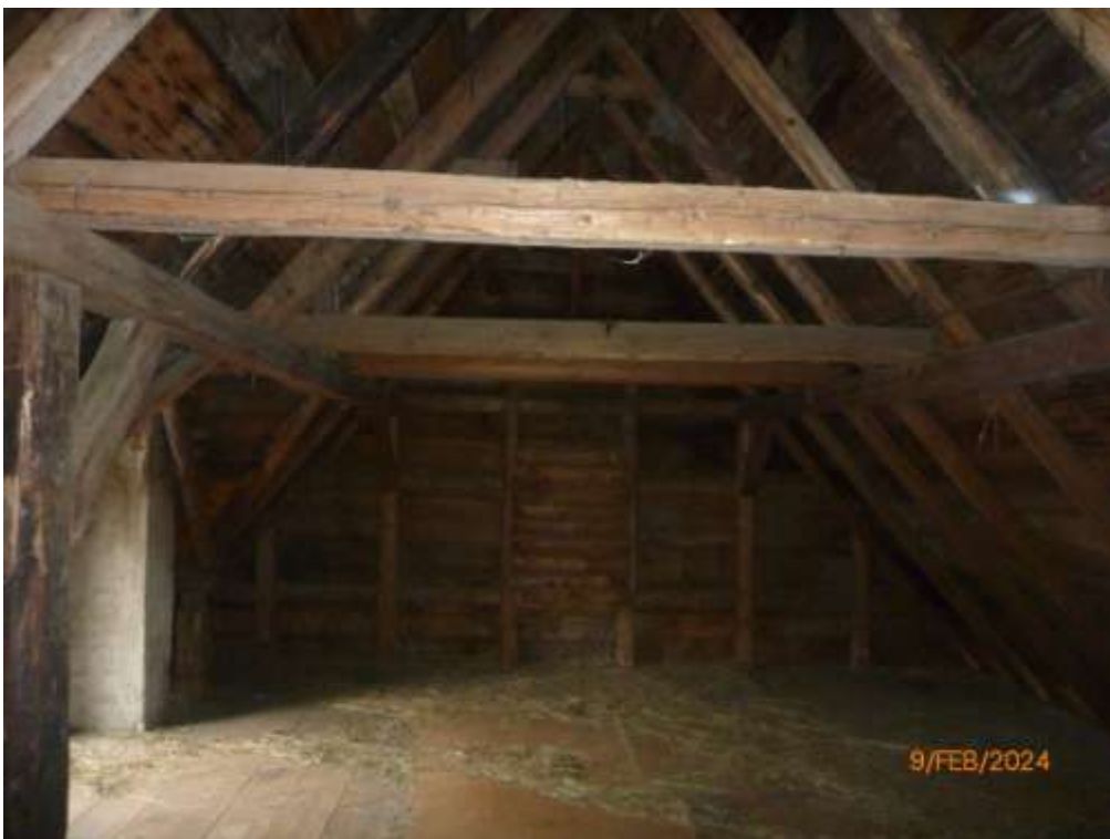
Bild 30: Dachboden des Nebengebäudes-III; links große Gaube zum Innenhof
