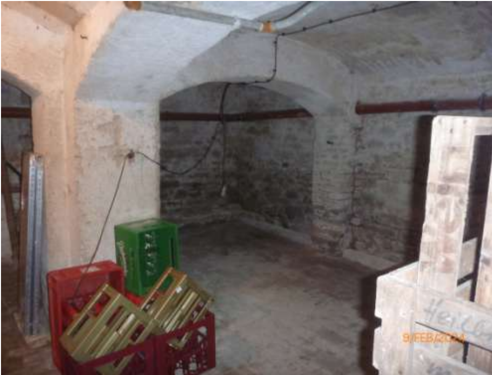
Bild 5: Wohngebäude-I; Räume im Kellergeschoss mit Gewölbedecken
