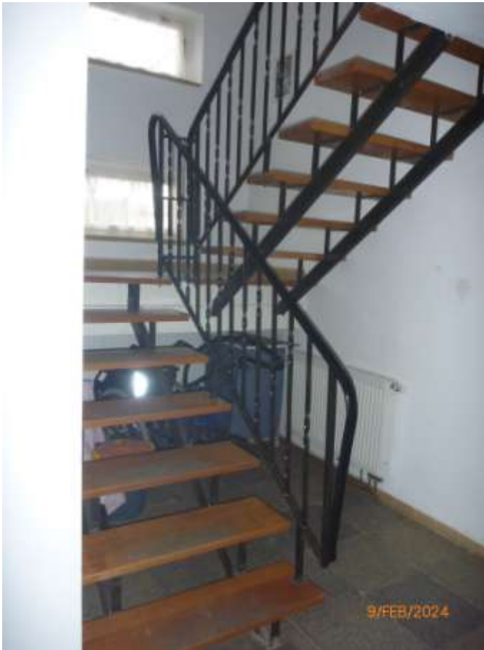
Bild 21: Wohngebäude-II; Treppenhaus zum Ober- geschoss
