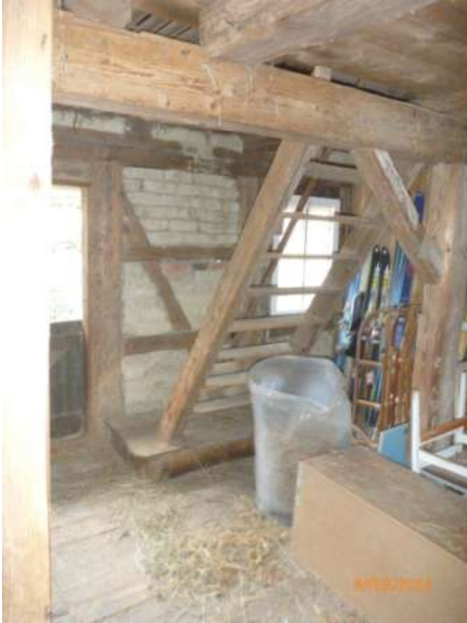
Bild 29: Obergeschoss des Nebengebäudes-III mit Holzstiege zum Dachboden
