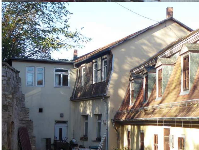
Hintergebäude mit Treppenhausanbau Foto 10
