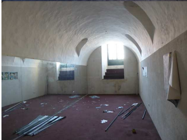
Kellergeschoß, Fitneßraum Foto 28
